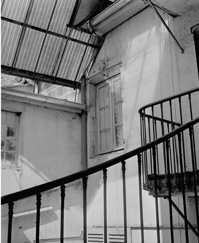
2e étage, fenêtre de gauche.
