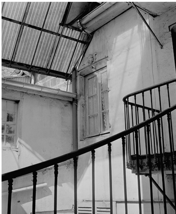
2e étage, fenêtre de gauche.
