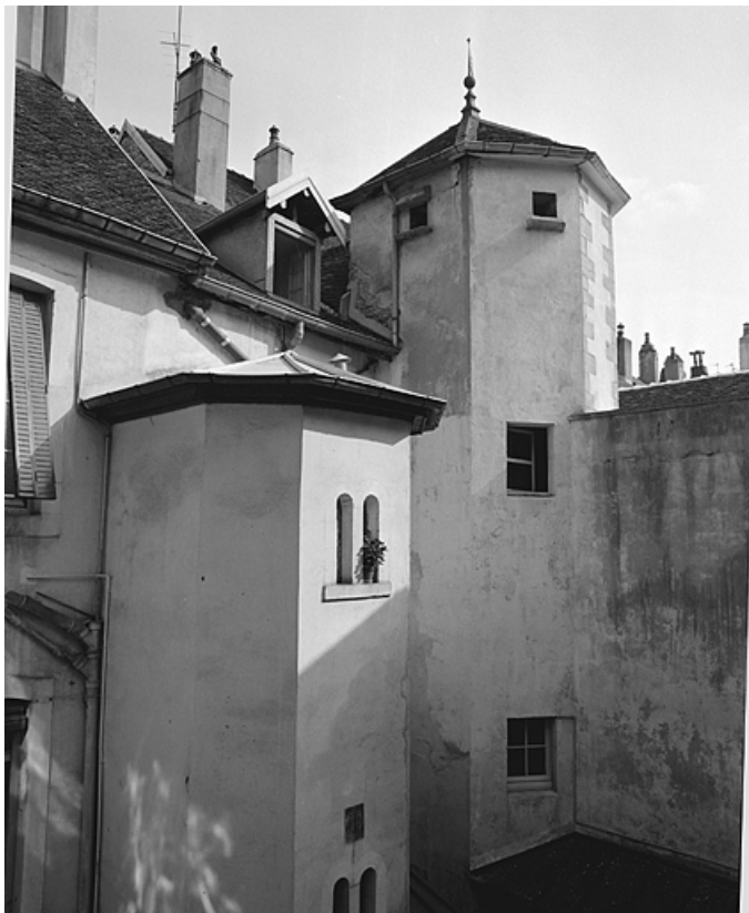
Tourelle d'escalier donnant sur la cour. 39, Lons-le-Saunier, 18 rue des Cordeliers
