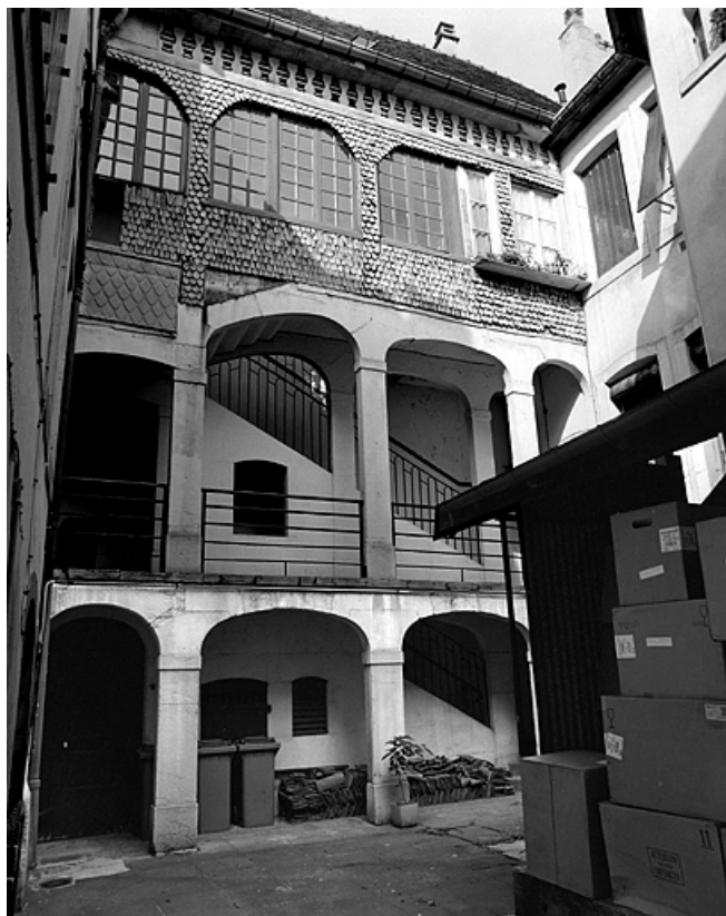
Escalier dans la cour, vue d'ensemble.
