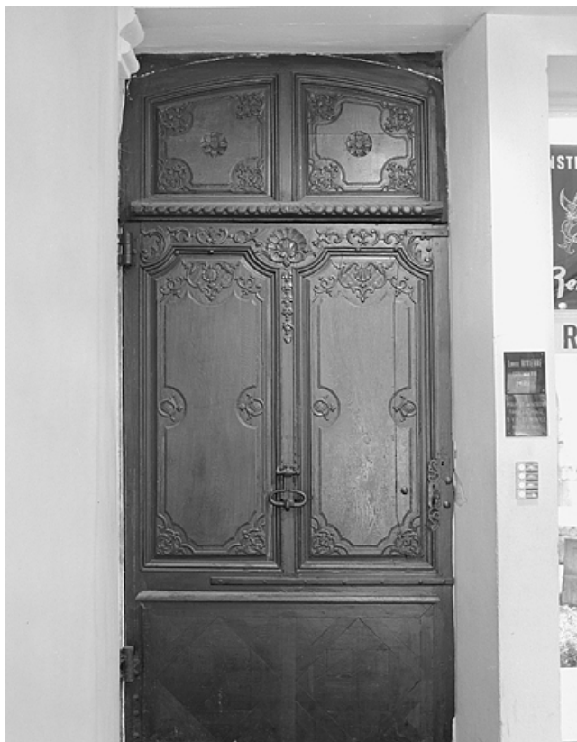
Porte de communication entre le couloir et la cour.
