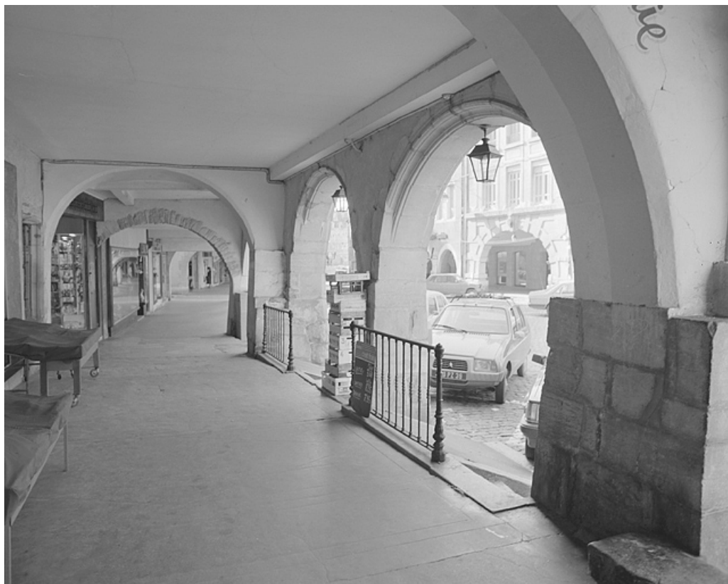
Façade antérieure, arcs moulurés du rez-de-chaussée vus depuis la galerie.
