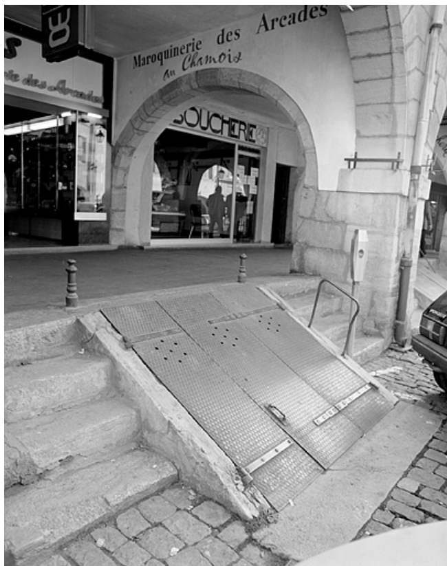
Descente de cave au-dessous de l'arc gauche de la façade antérieure.
