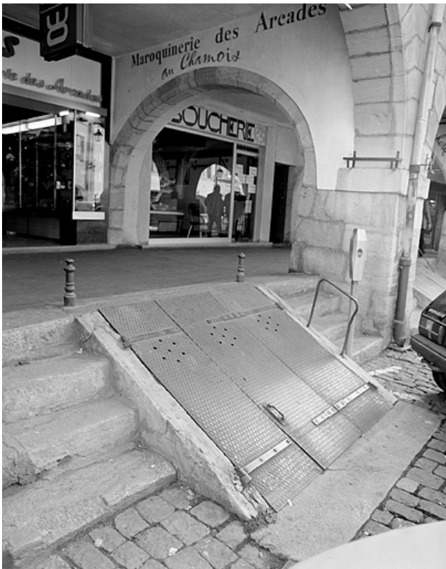
Descente de cave au-dessous de l'arc gauche de la façade antérieure. 39, Lons-le-Saunier, 39 rue du Commerce
