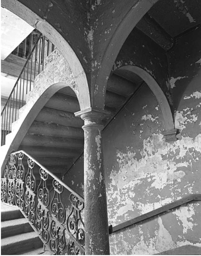
Escalier vu depuis le premier palier.
