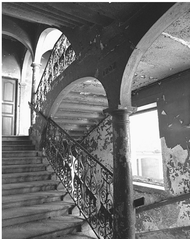
Vue de l'escalier depuis le premier repos, avec écoinçon portant la date 1707. 39, Lons-le-Saunier, 32 rue du Commerce
