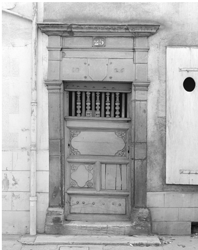
Façade latérale, porte d'entrée avec la date 1726.
