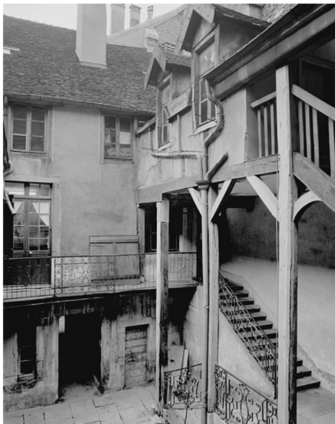
Vue de la cour intérieure avec l'escalier.
