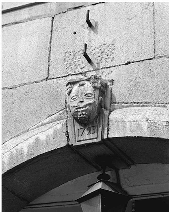
Façade antérieure, détail de l'arc central portant la date 1723. 39, Lons-le-Saunier, 24 rue du Commerce
