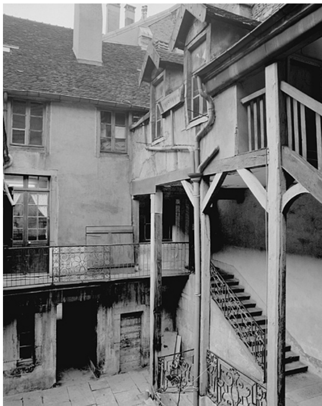
Vue de la cour intérieure avec l'escalier.
