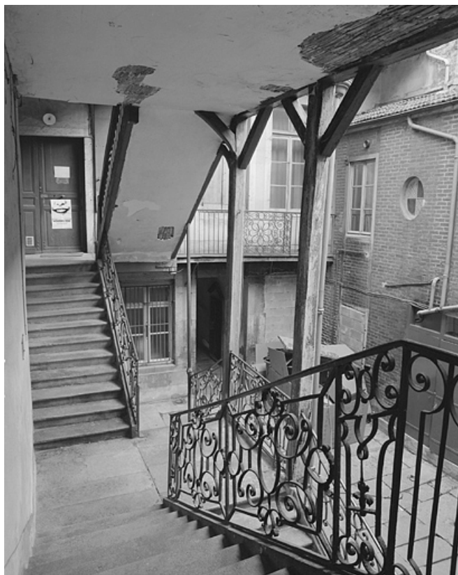
Escalier dans la cour, vu depuis le premier palier.
