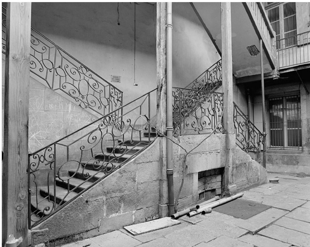
Escalier dans la cour, vu depuis la cour, premières volées.
