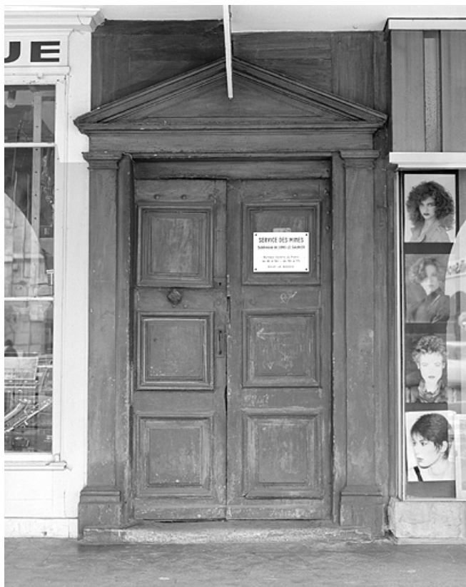
Façade antérieure, porte d'entrée donnant sur la galerie ouverte du rez-de-chaussée. 39, Lons-le-Saunier, 24 rue du Commerce
