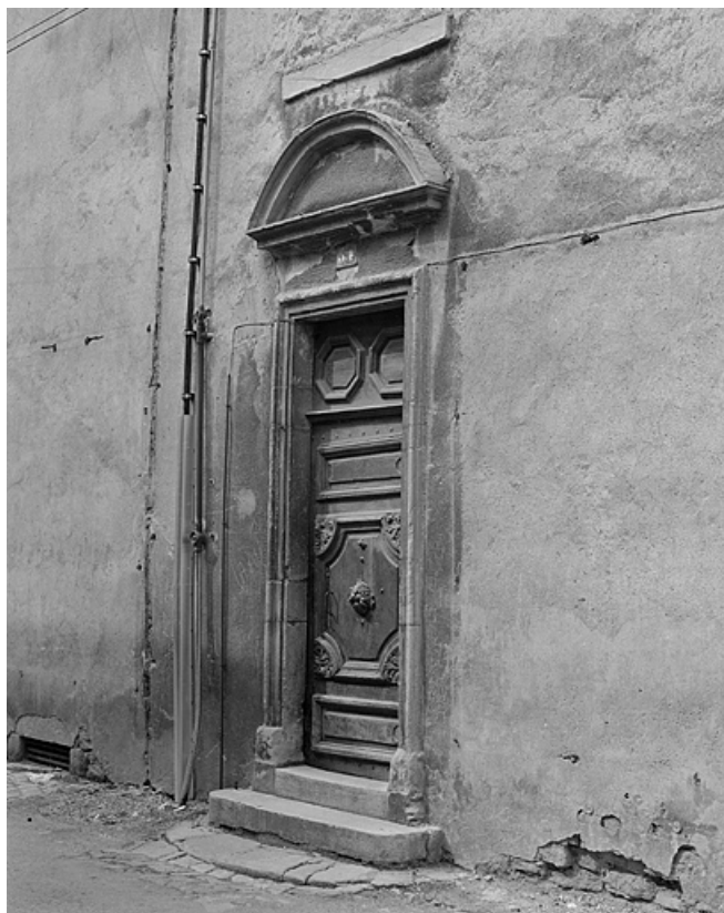
Façade latérale, porte d'entrée.
