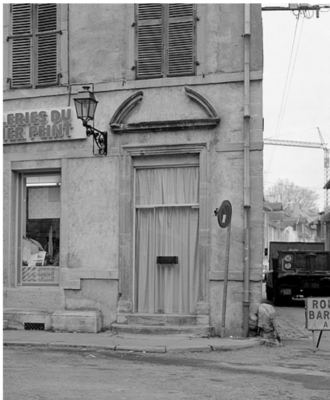
Façade antérieure, porte d'entrée.
