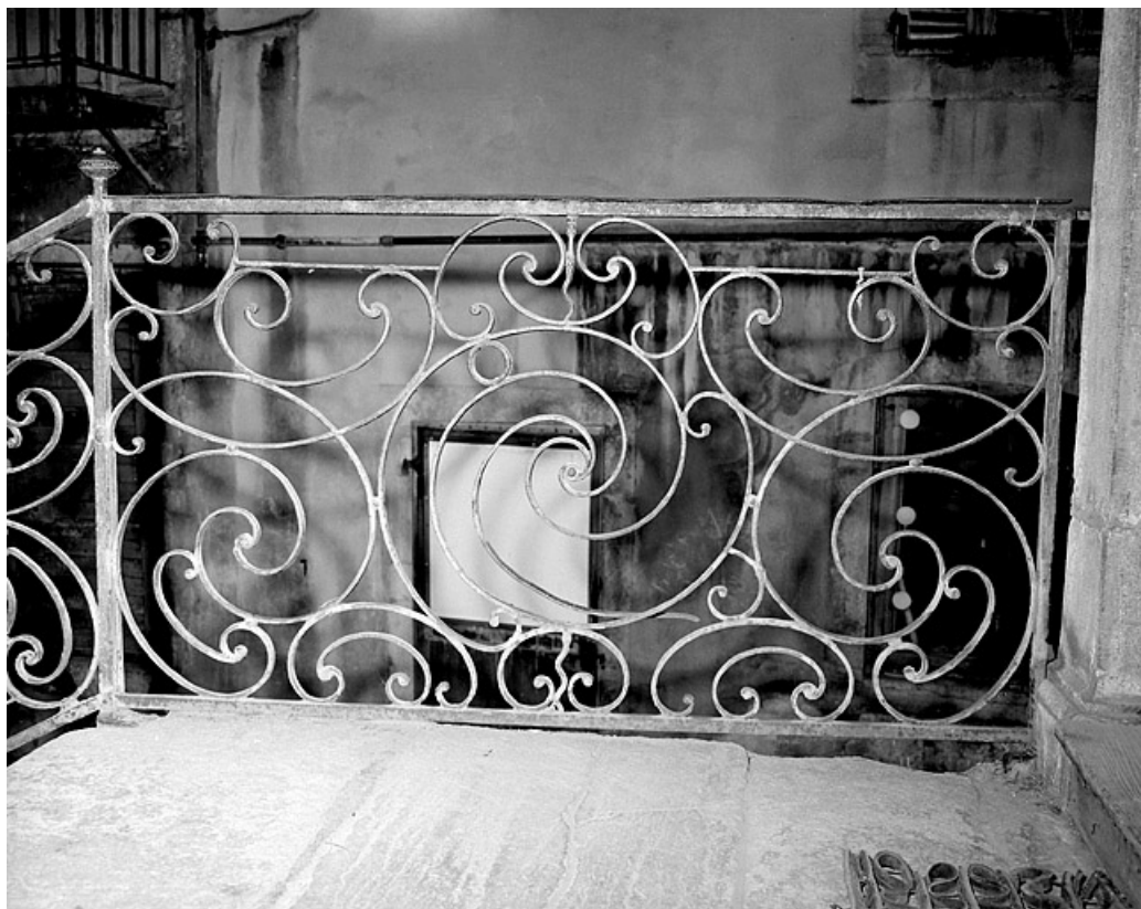
Escalier intérieur à cage ouverte sur la cour. Détail de la rampe.
