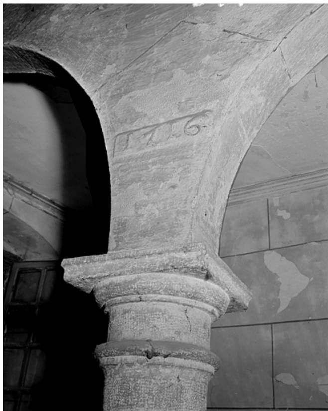
Escalier, détail de l'arc rampant portant la date 1716.
