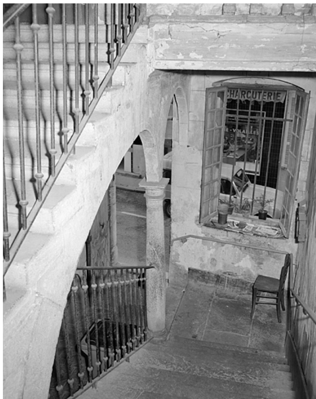
Escalier vu depuis le premier repos.
