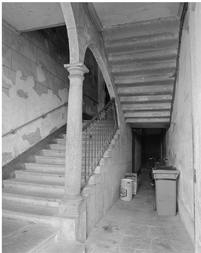
Vue de l'escalier depuis le vestibule.
