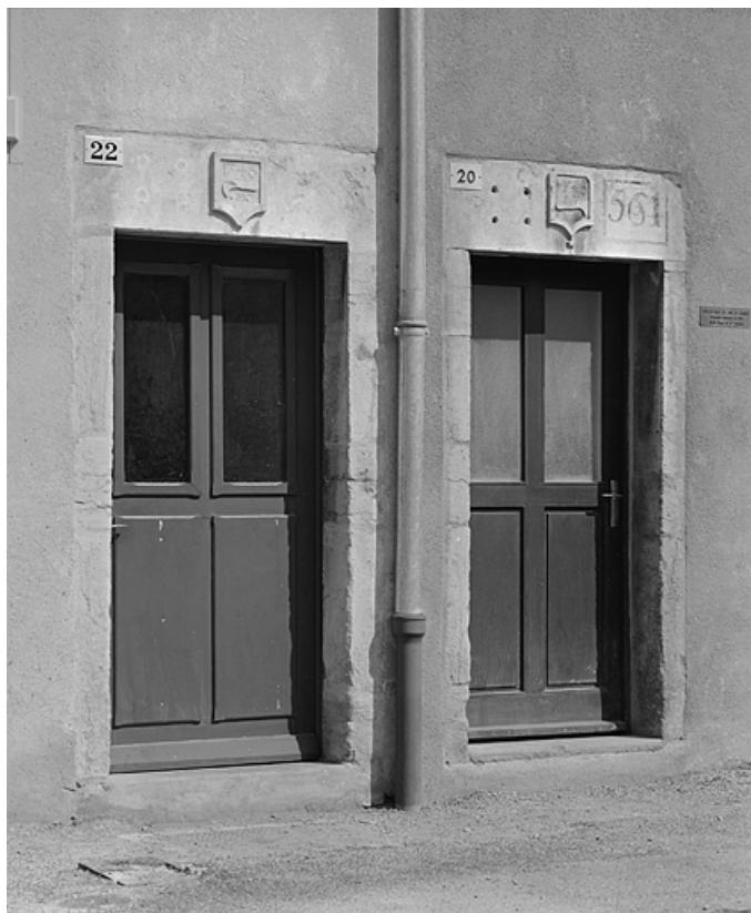
Détail des portes d'entrée du 20 et du 22 rue de la Comédie.
