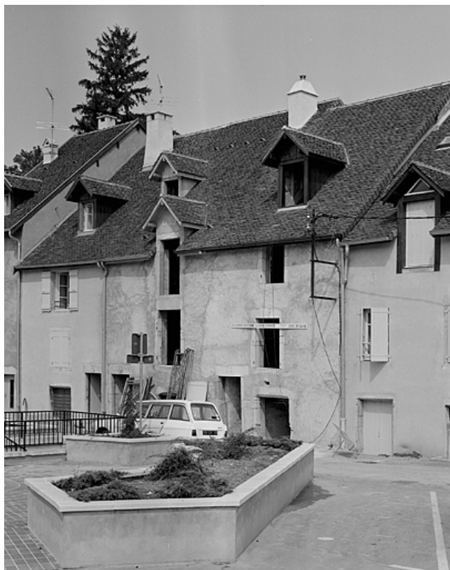
Façade antérieure avant réfection de l'enduit.
