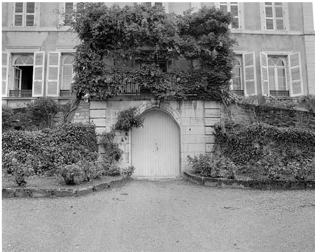
Façade antérieure, entrée de la cave et rampe d'accès au 1er étage.
