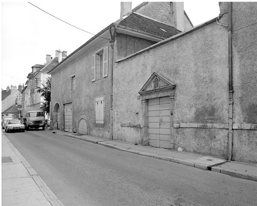
Façade antérieure, partie centrale.
