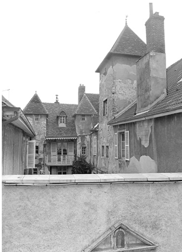
Vue partielle des façades sur la cour.
