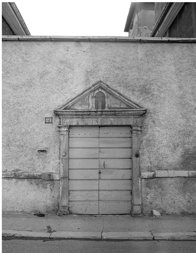
Façade antérieure, porte d'entrée.
