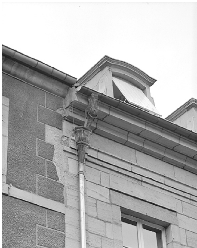
Façade antérieure, détail de la partie supérieure de l'élévation. 39, Lons-le-Saunier, 8 rue Sébile
