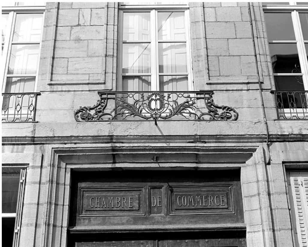
Façade antérieure, garde-corps de la fenêtre centrale.
