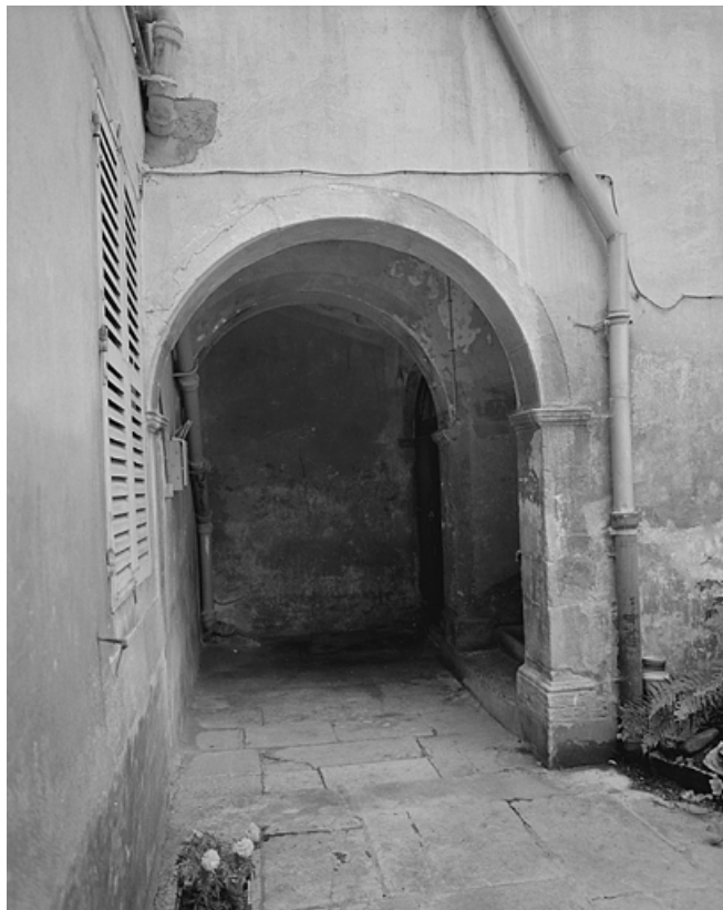
Arc donnant accès à l'escalier vu depuis la cour.
