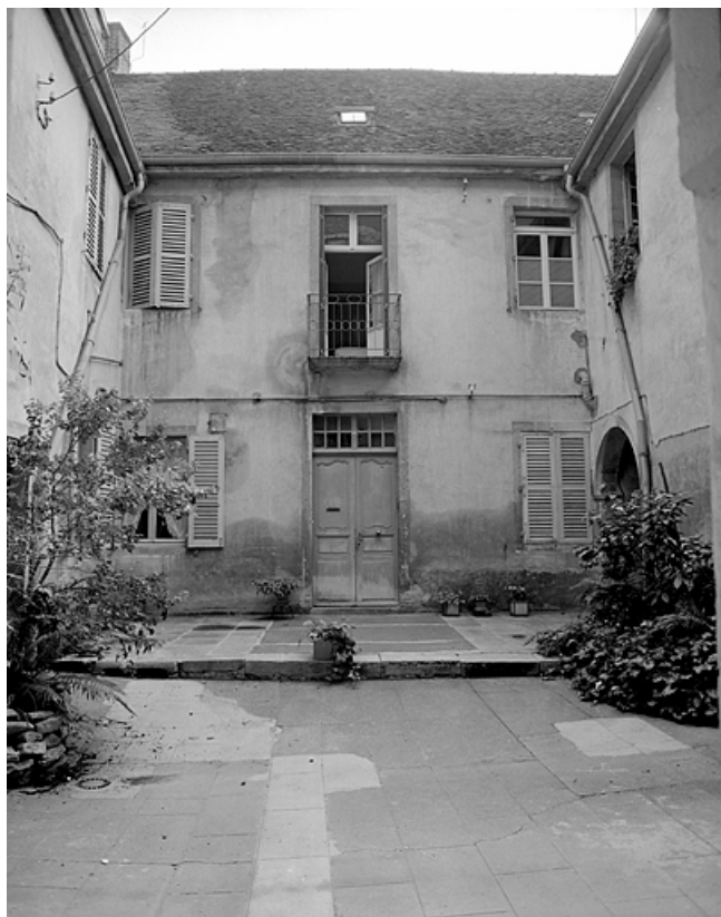
Façade sur cour du second corps de bâtiment.
