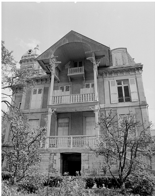
Façade postérieure, partie centrale. 39, Lons-le-Saunier, 94 rue Saint-Désiré
