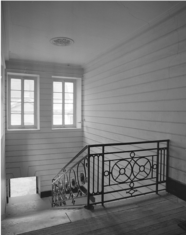
Vue de l'escalier depuis le palier.
