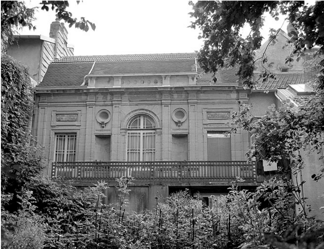
Façade sur jardin du second corps de bâtiment.
