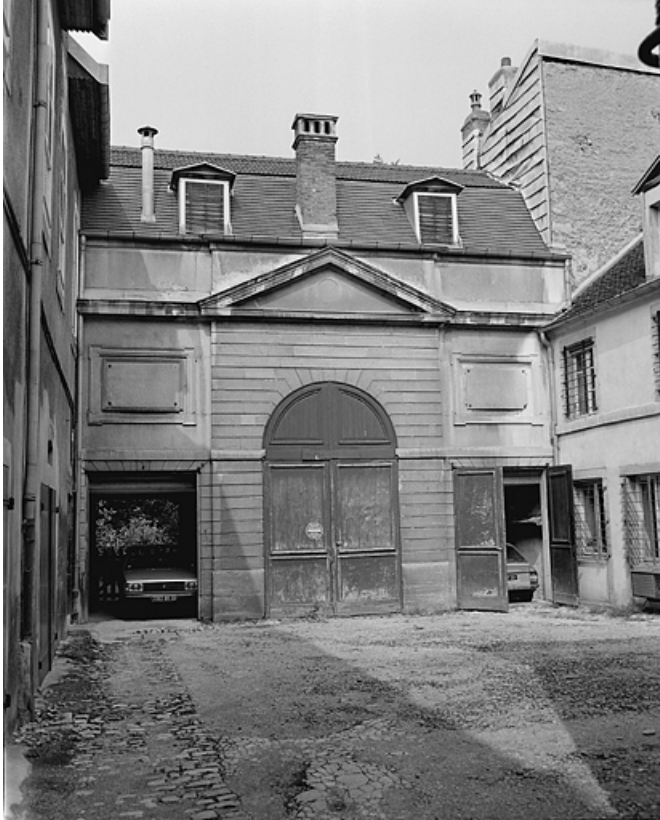
Façade sur cour du second corps de bâtiment.
