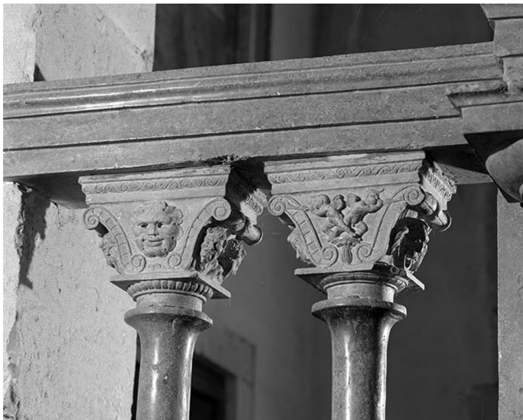
Intérieur : détail des chapiteaux de la partie gauche de la clôture de la chapelle du baptistère. 39, Lons-le-Saunier, 22 rue Saint-Désiré
