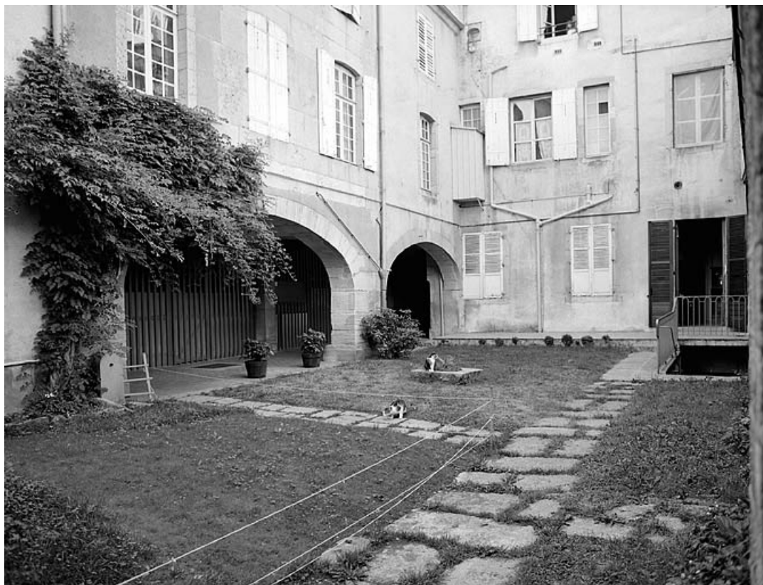
Vue de la cour intérieure.
