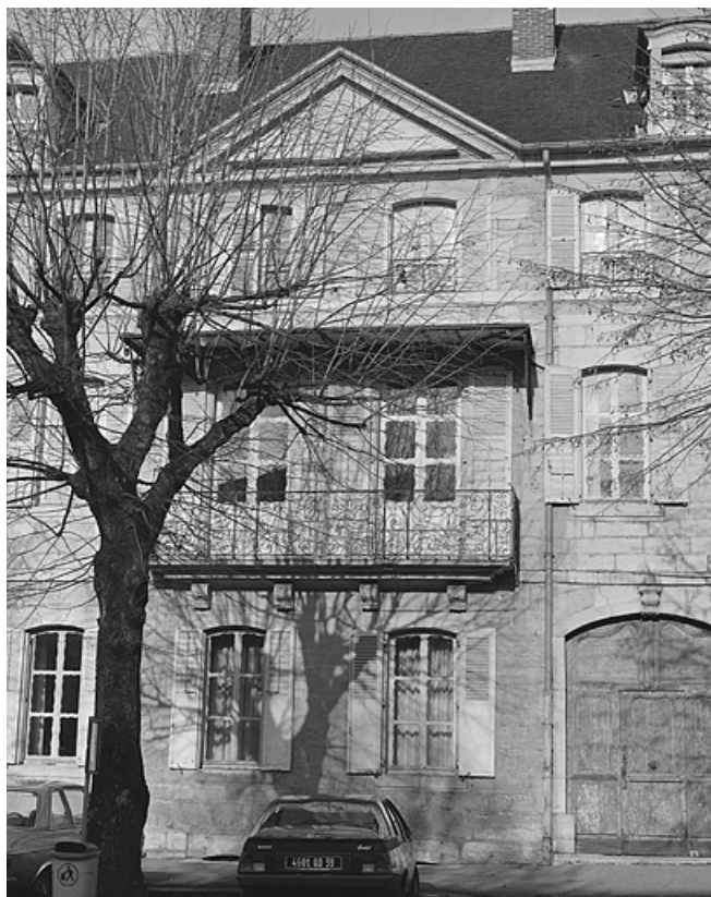
Façade antérieure, partie centrale. 39, Lons-le-Saunier, 8 place Perraud
