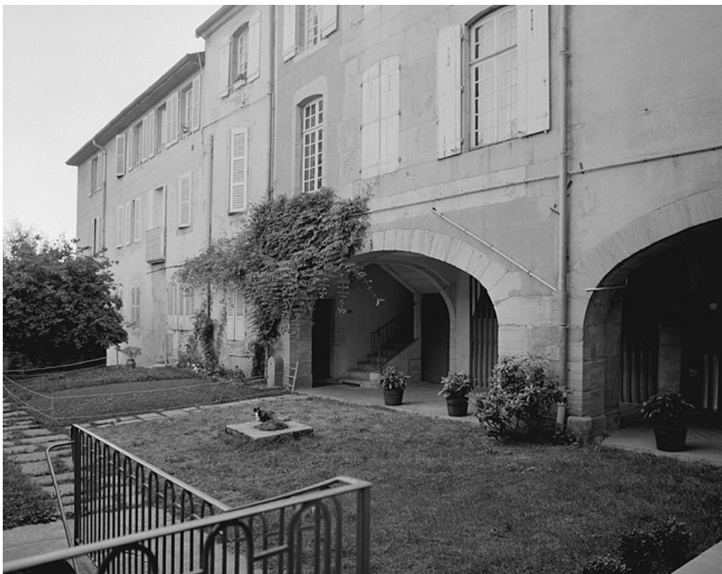
Façade sur cour de l'aile en retour d'équerre.
