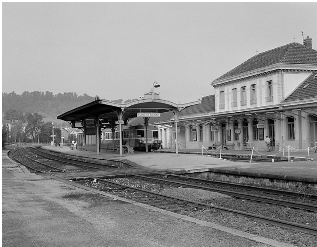
Façade postérieure et abri sur le quai. 39, Lons-le-Saunier boulevard Gambetta
