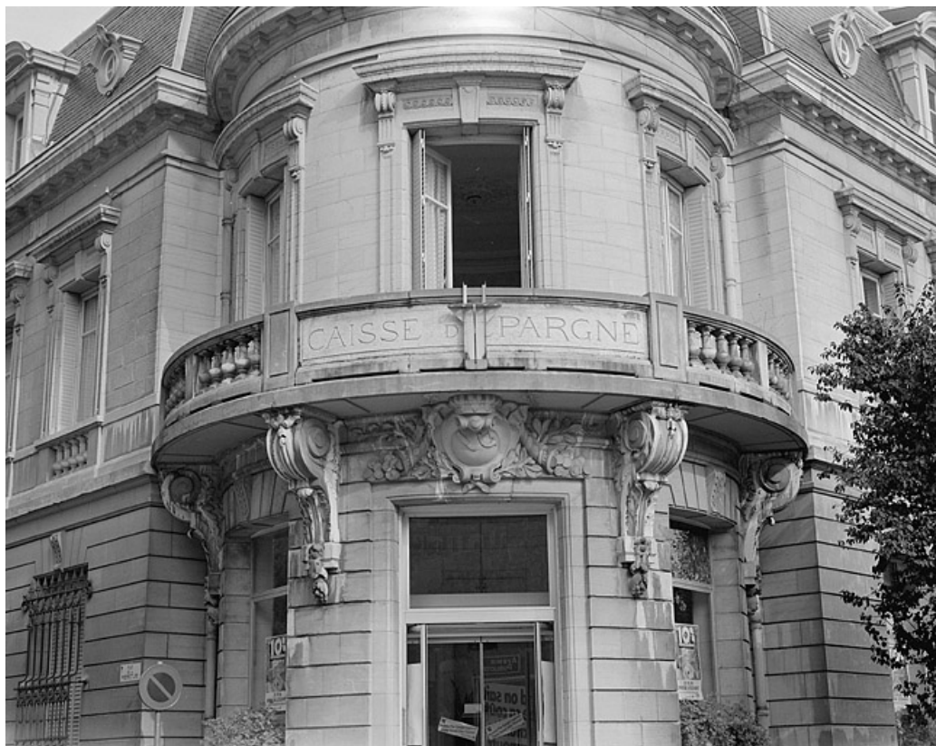
Détail de la rotonde de la façade principale. 39, Lons-le-Saunier, 8 avenue Aristide Briand
