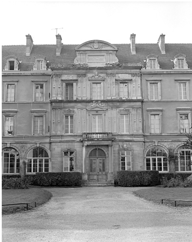
Façade antérieure, avant-corps central.
