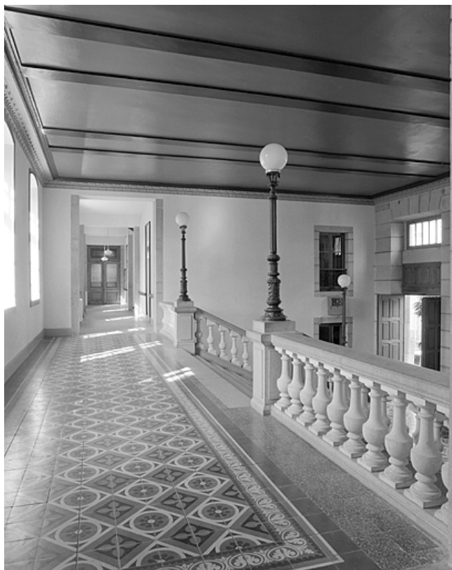
Grand escalier, vue depuis le palier au 1er étage.
