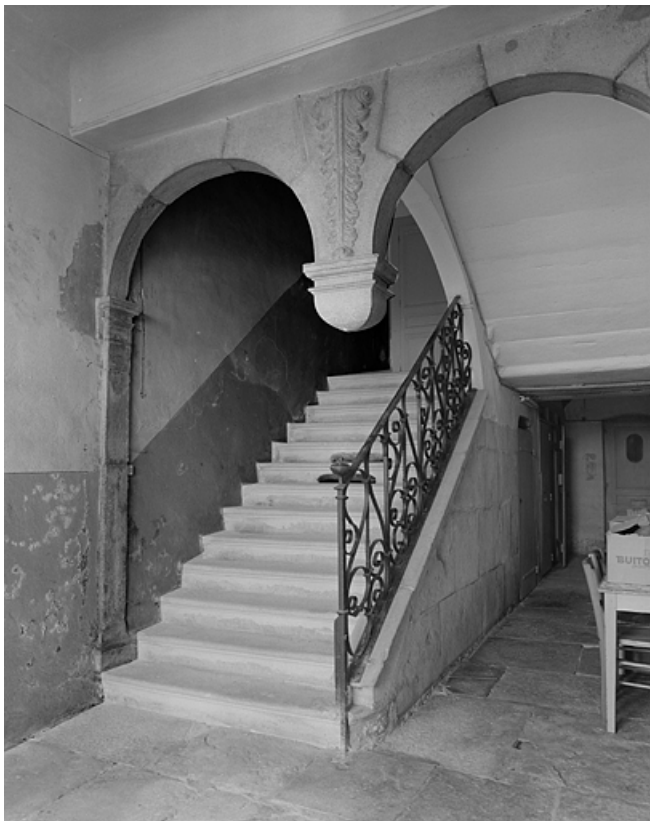
Détail de l'escalier intérieur dans le corps de bâtiment sur rue. 39, Lons-le-Saunier, 1 rue Sébile
