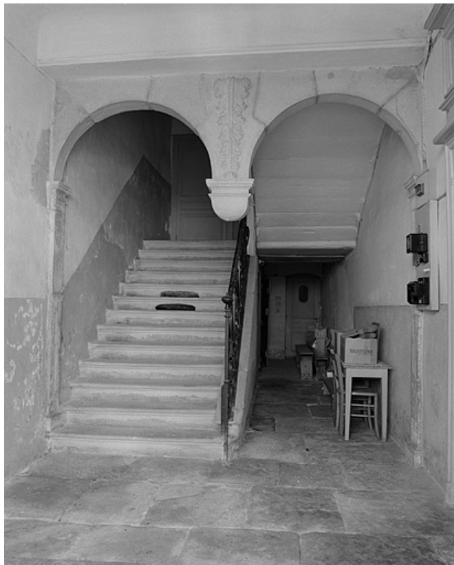
Escalier intérieur dans le corps de bâtiment sur rue, vue générale. 39, Lons-le-Saunier, 1 rue Sébile
