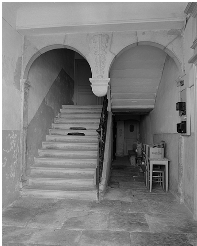
Escalier intérieur dans le corps de bâtiment sur rue, vue générale. 39, Lons-le-Saunier, 1 rue Sébile
