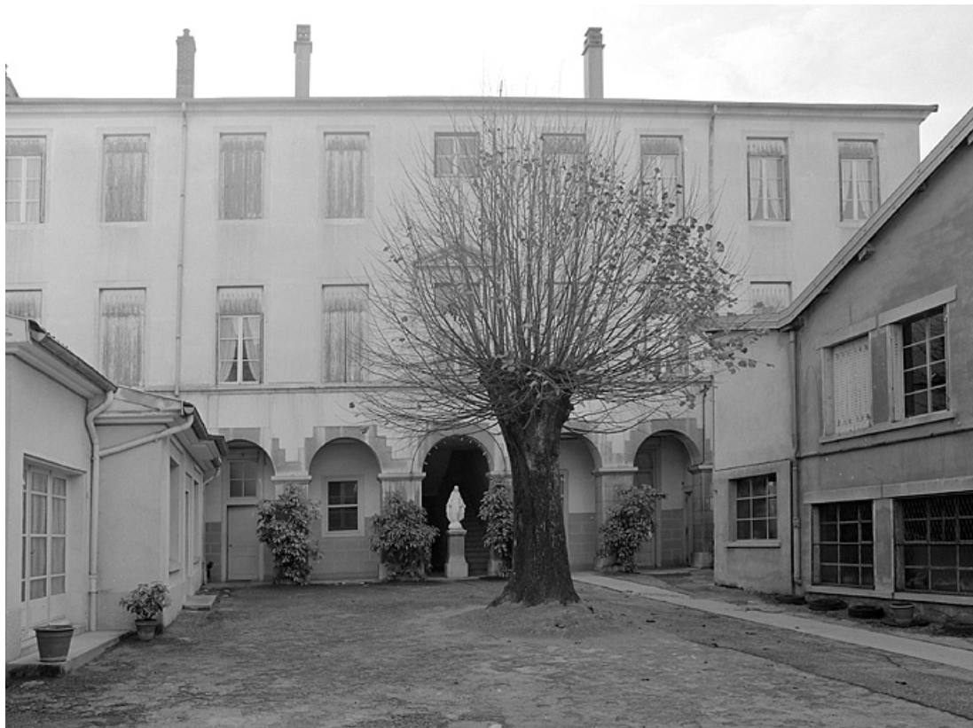
Bâtiment annexe, façade sur la cour.
