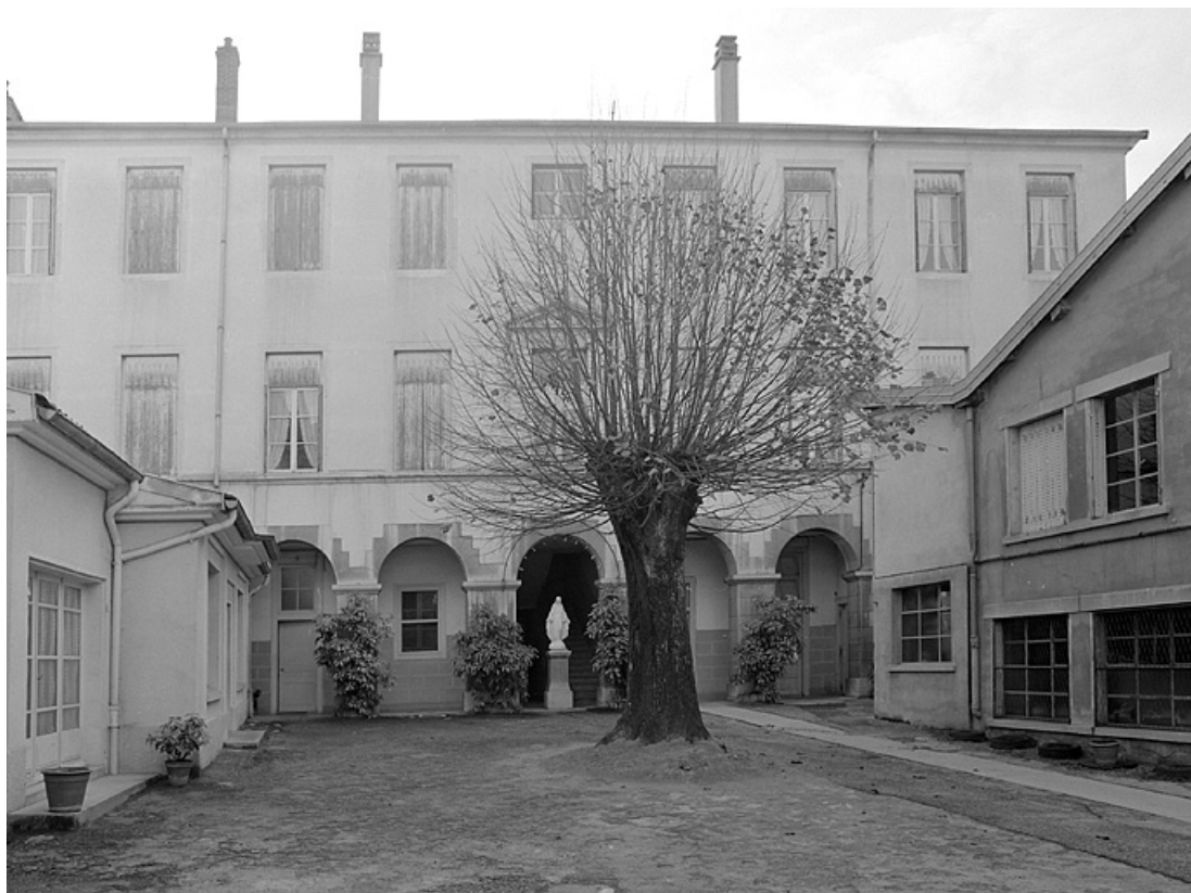
Bâtiment annexe, façade sur la cour.
