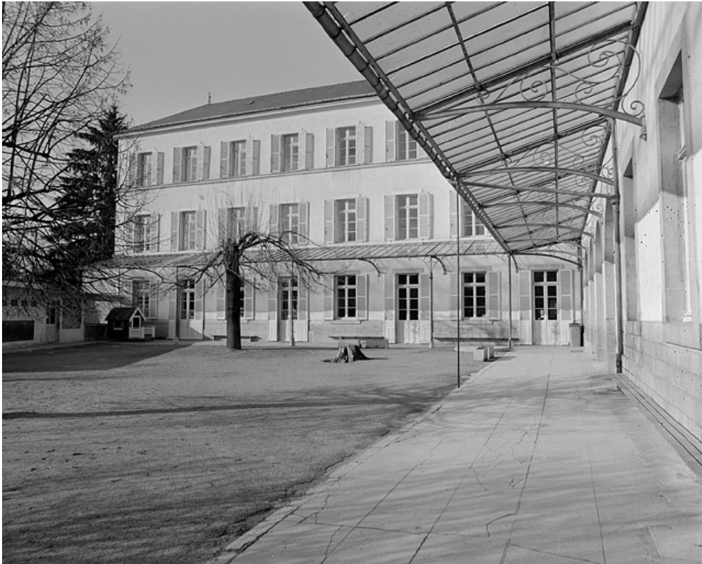
Façade sur cour de l'aile gauche en retour.
