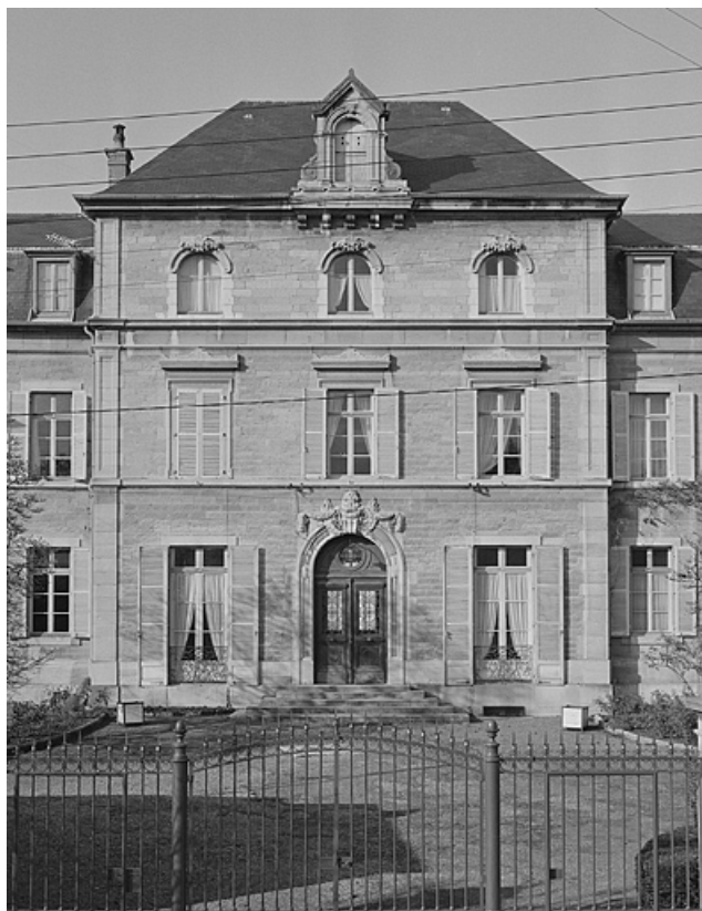
Façade antérieure, avant-corps central.
