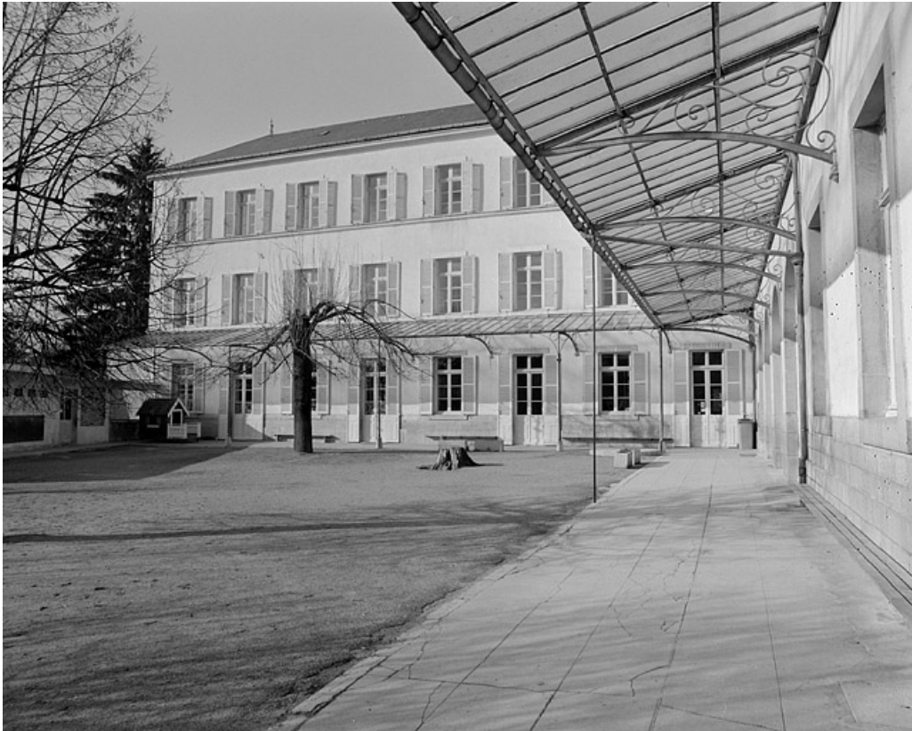
Façade sur cour de l'aile gauche en retour. 39, Lons-le-Saunier, 2 rue Georges Trouillot
