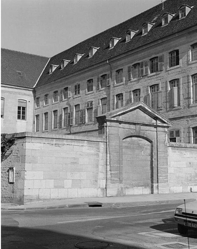
Façade latérale de l'aile gauche en retour et faux portail.
