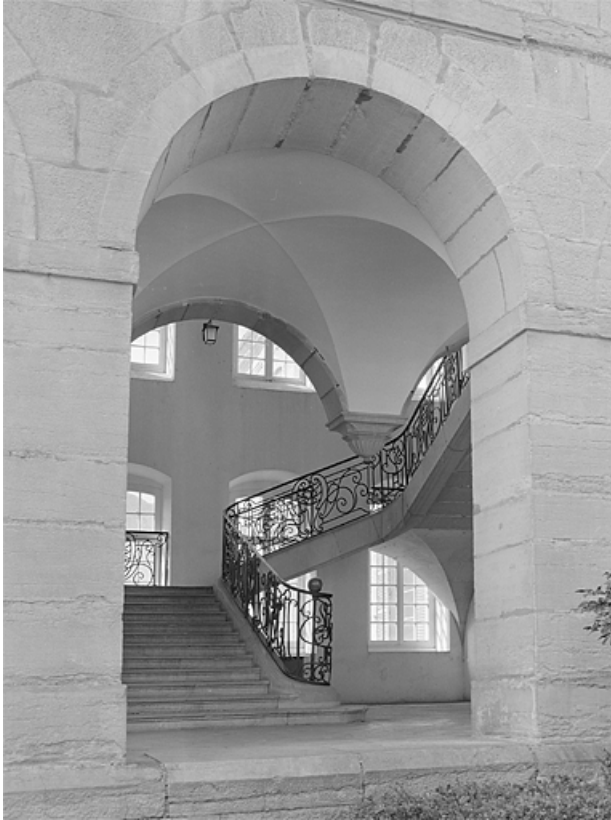
Départ du grand escalier vu à travers une arcade de la galerie bordant la cour. 39, Lons-le-Saunier place de l' Hôtel de Ville
