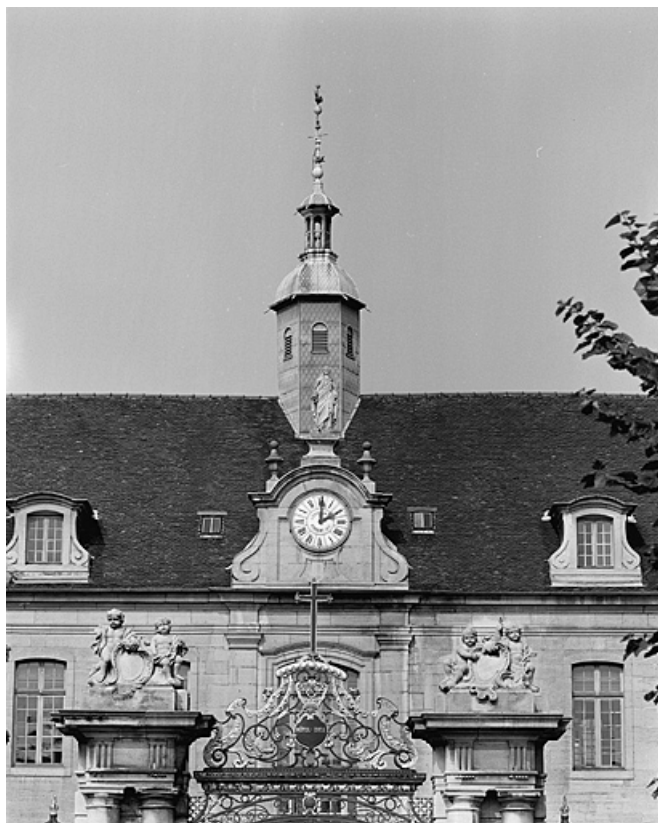
Façade principale sur la cour, détail de la partie centrale.
