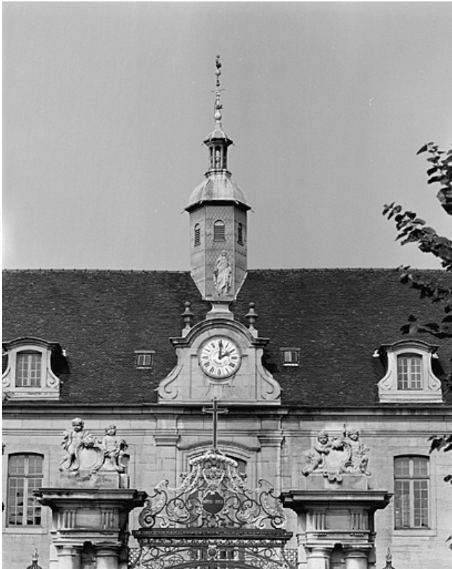
Façade principale sur la cour, détail de la partie centrale.
