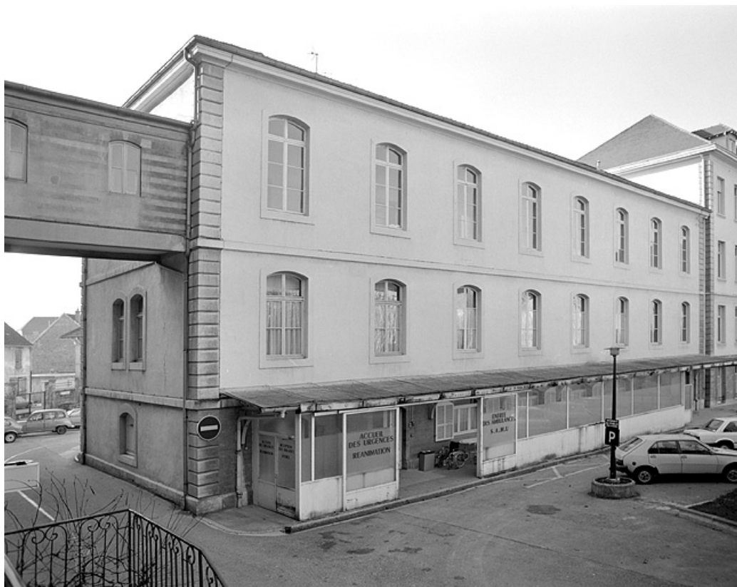
Bâtiment annexe (Pavillon sud) depuis la cour.
