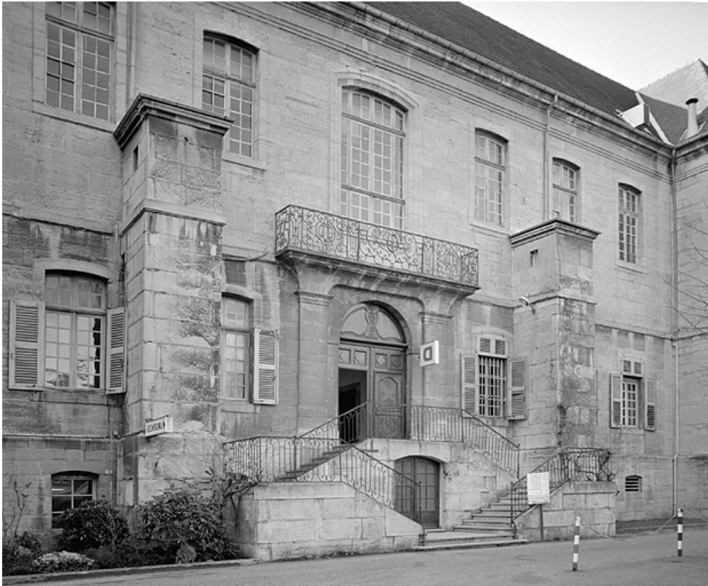
Façade postérieure, escalier extérieur.
