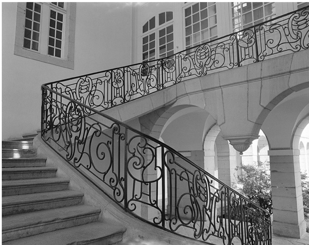
Vue d'ensemble du grand escalier et de la galerie bordant la cour.
