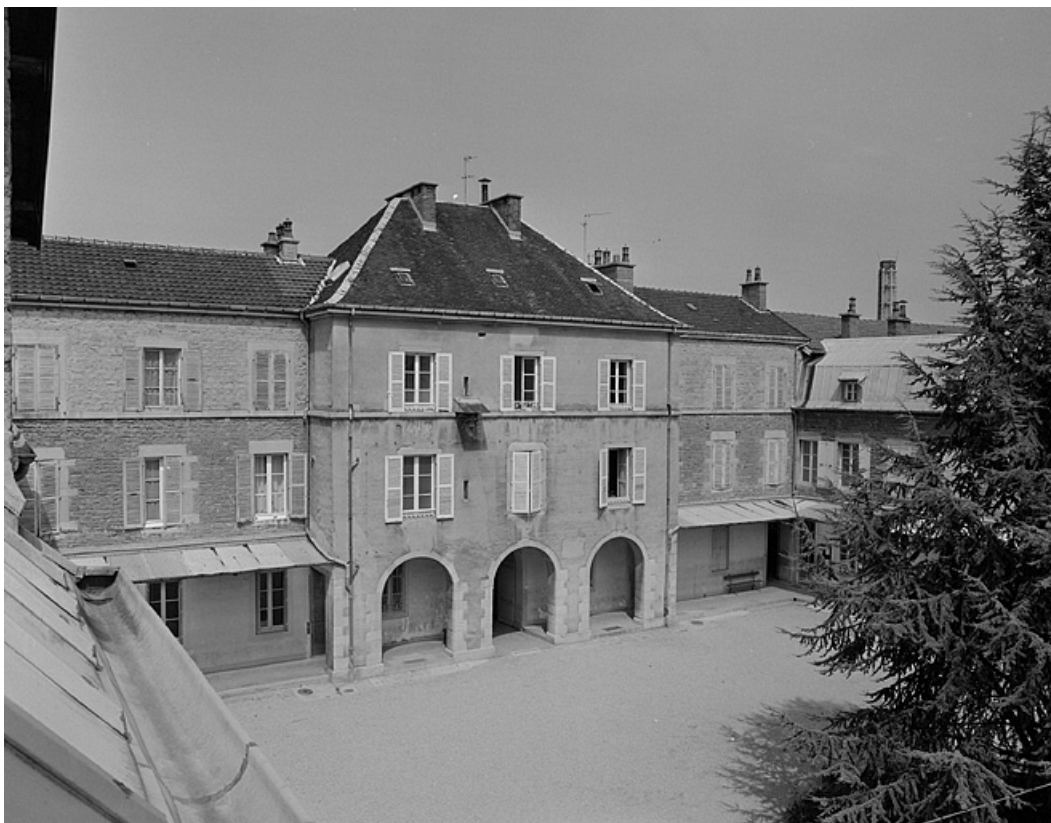
Pavillon d'entrée, vue de la cour intérieure.
