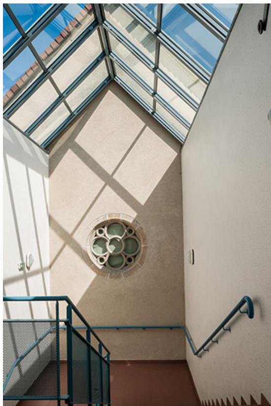
Chapelle : chevet, jonction avec l'extension sud
