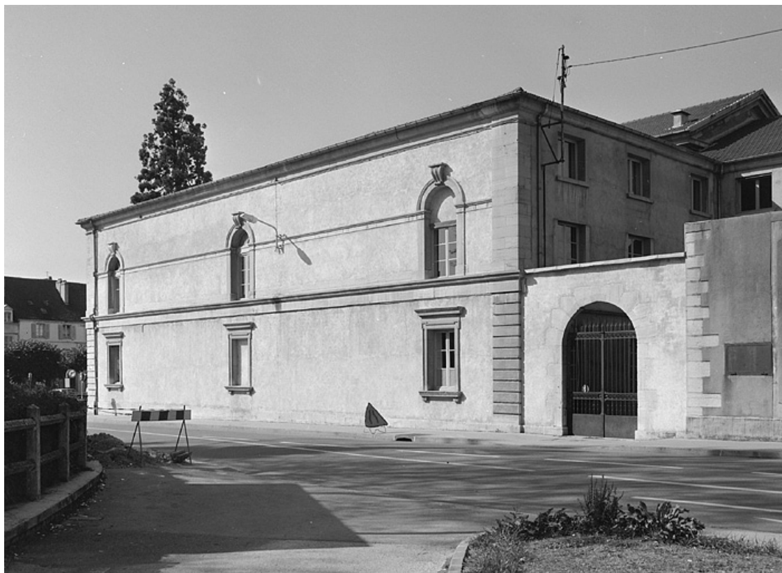
Façade latérale sur la rue de la Chevalerie.
