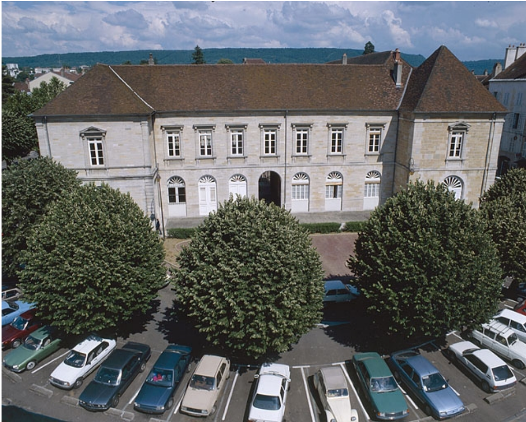
Façade ouest, vue d'ensemble.
