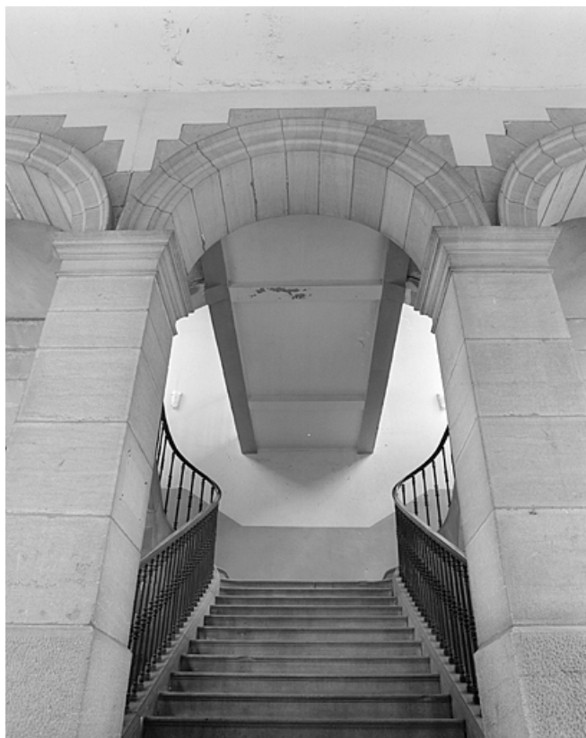
Escalier conduisant au Tribunal et à la Bibliothèque.
