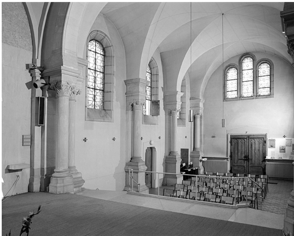
Eglise : élévation intérieure et voûtement de la nef.
