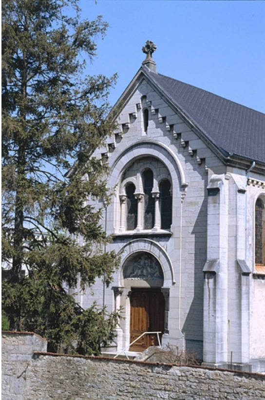
Façade antérieure de la chapelle.
