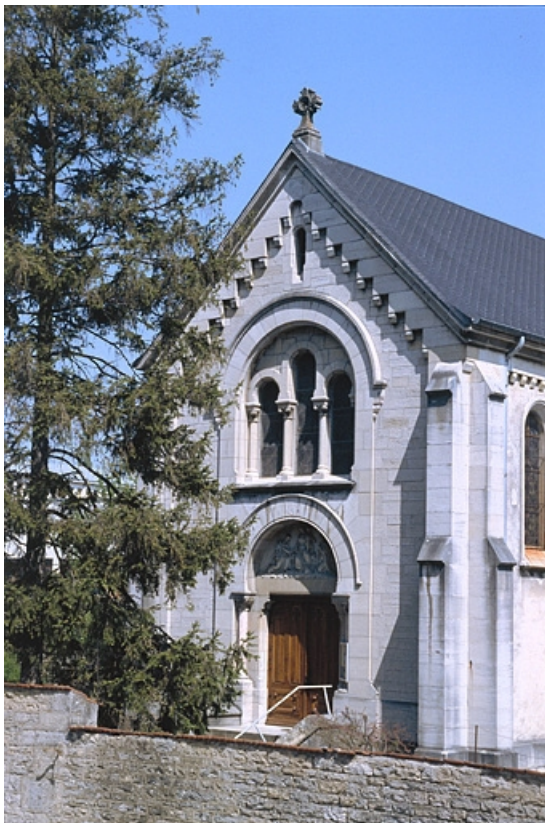
Façade antérieure de la chapelle.
