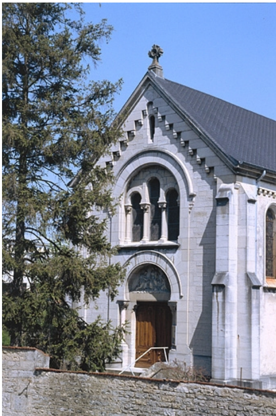
Façade antérieure de la chapelle.
