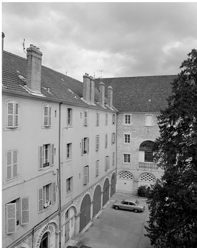
Bâtiments conventuels, cour intérieure, façade ouest.
