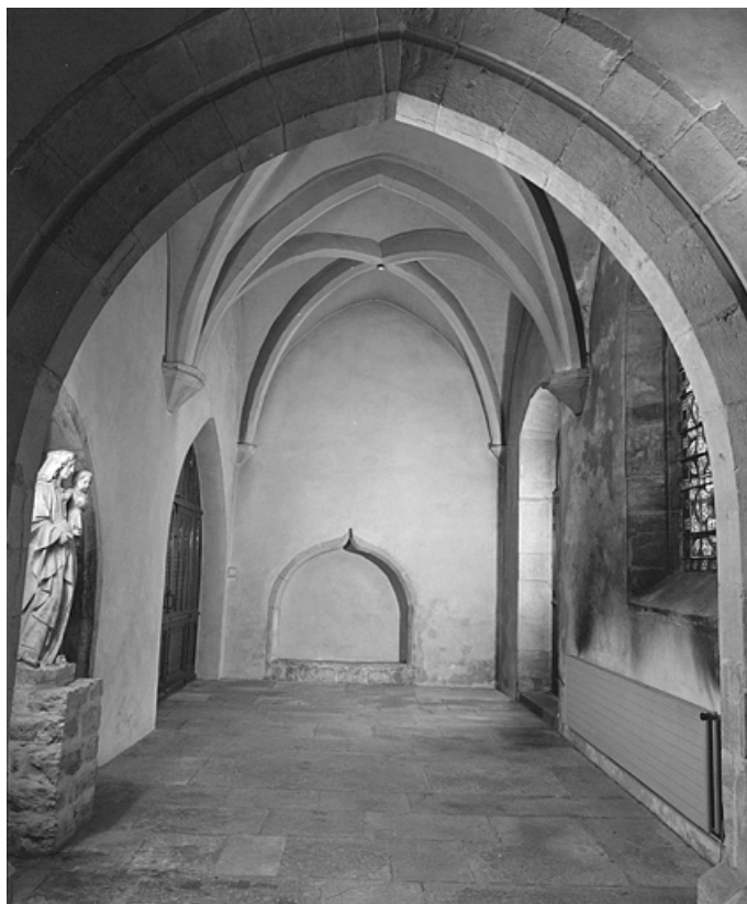
Eglise, quatrième chapelle gauche, vue depuis l'est.
