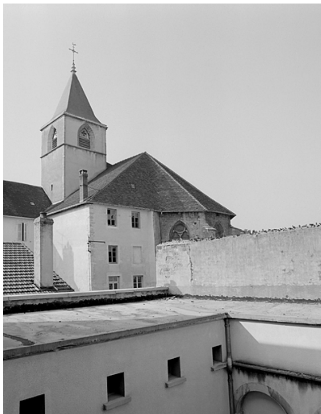
Eglise, vue générale du chevet et du clocher.
