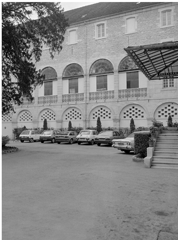
Bâtiments conventuels, cour intérieure, façade nord.
