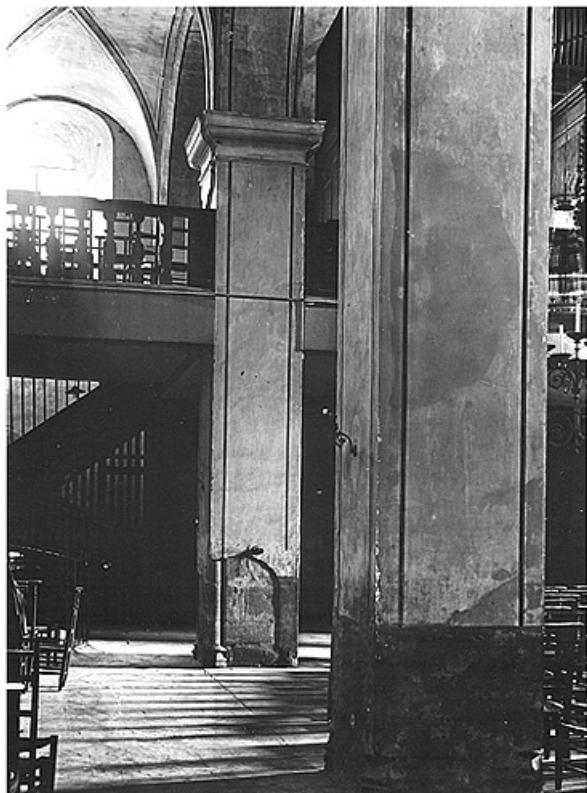
Eglise : vue du bas-côté montrant un pilier où l'on a partiellement enlevé le décor du 18e siècle, laissant voir l'état d'origine. 39, Lons-le-Saunier rue des Cordeliers
