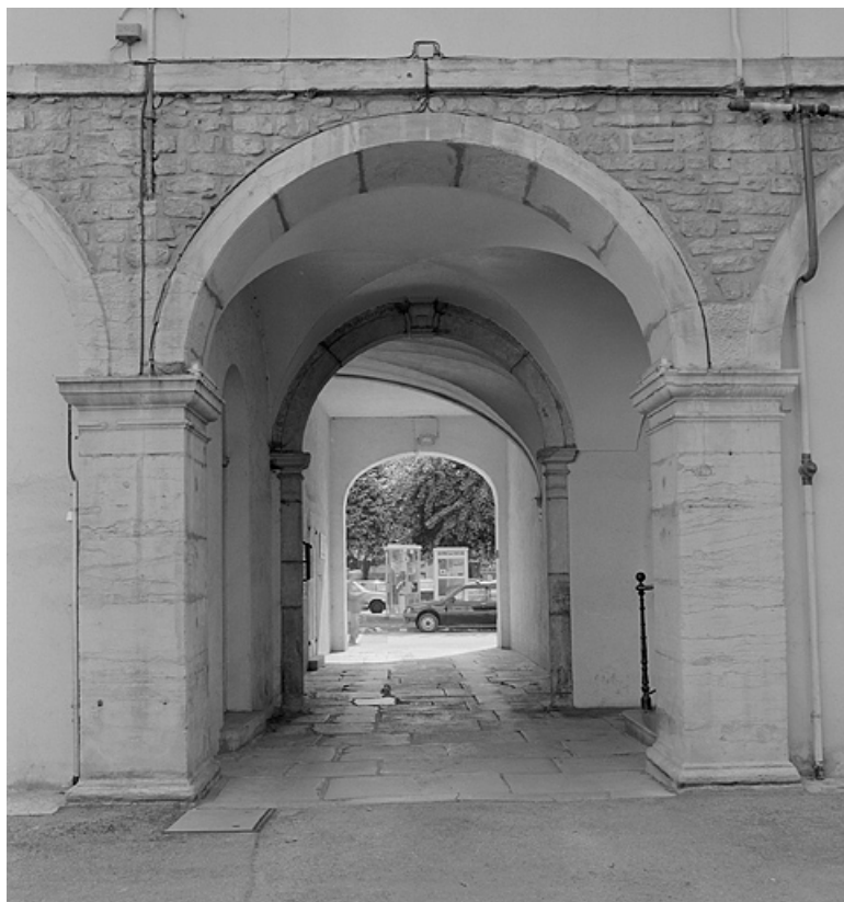
Bâtiments conventuels, le passage d'entrée vu depuis le cloître.
