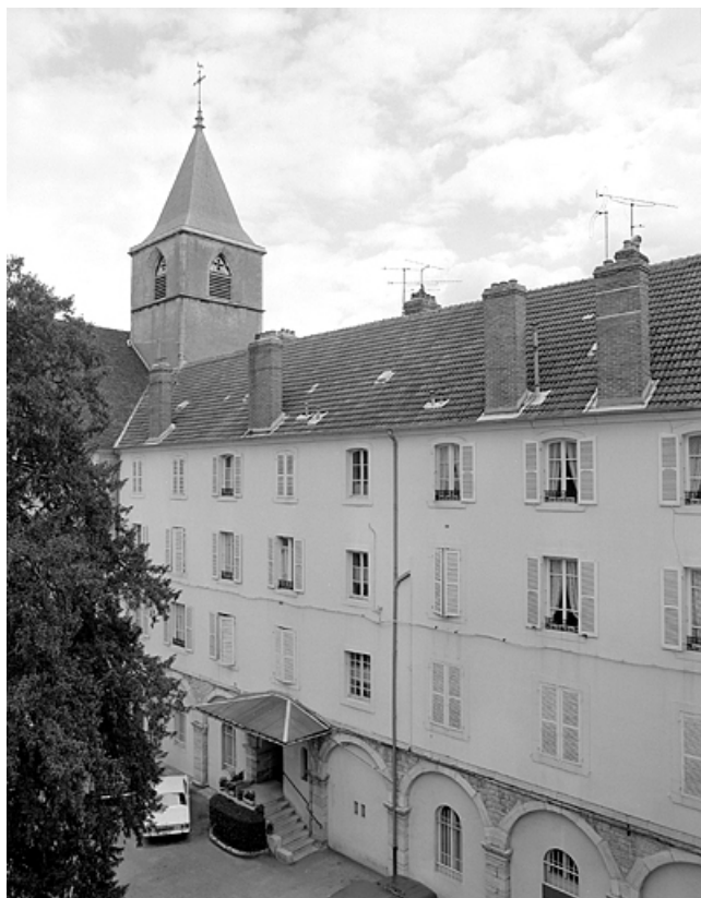
Bâtiments conventuels, cour intérieure, façade est. 39, Lons-le-Saunier rue des Cordeliers
