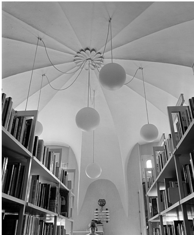
Bâtiments conventuels, voûte de l'ancienne cuisine.
