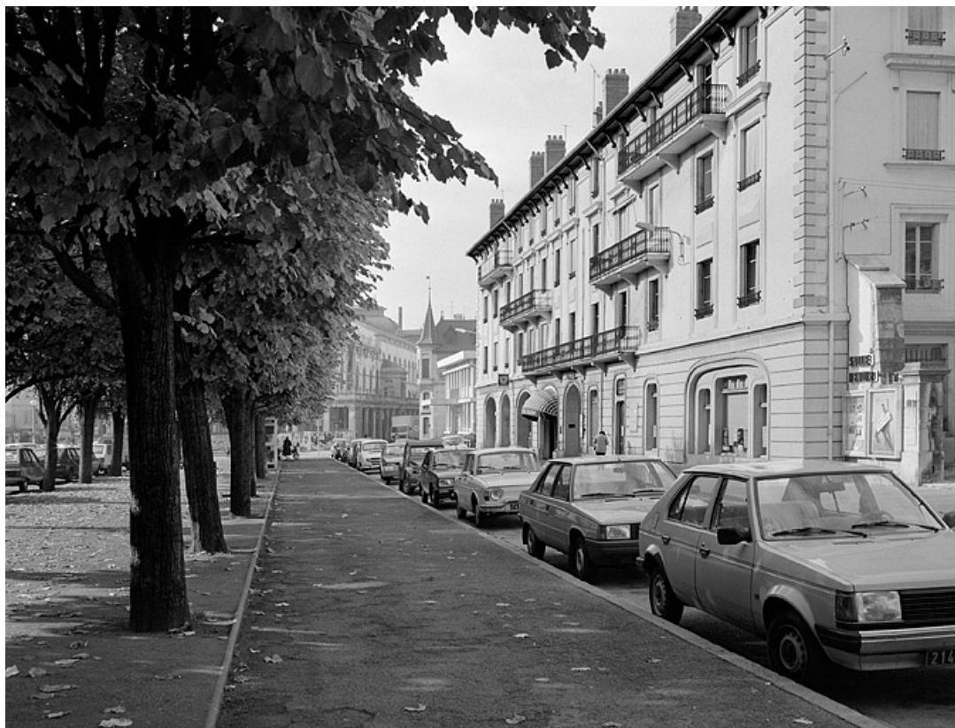
Anciens bâtiments conventuels. Façade sur la rue Pasteur.
