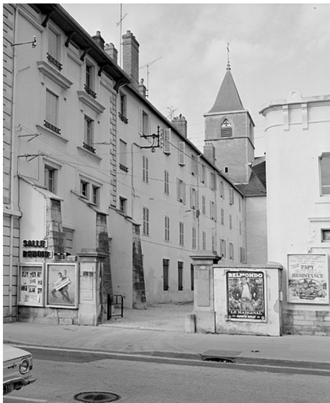
Anciens bâtiments conventuels. Façade latérale est.
