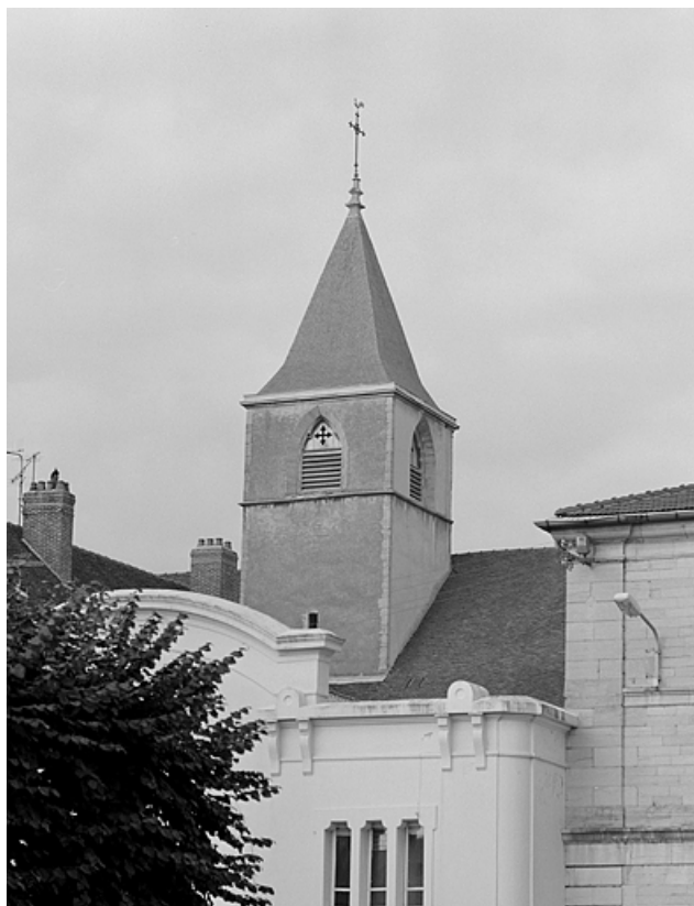
Clocher de l'église vu depuis la rue Pasteur.
