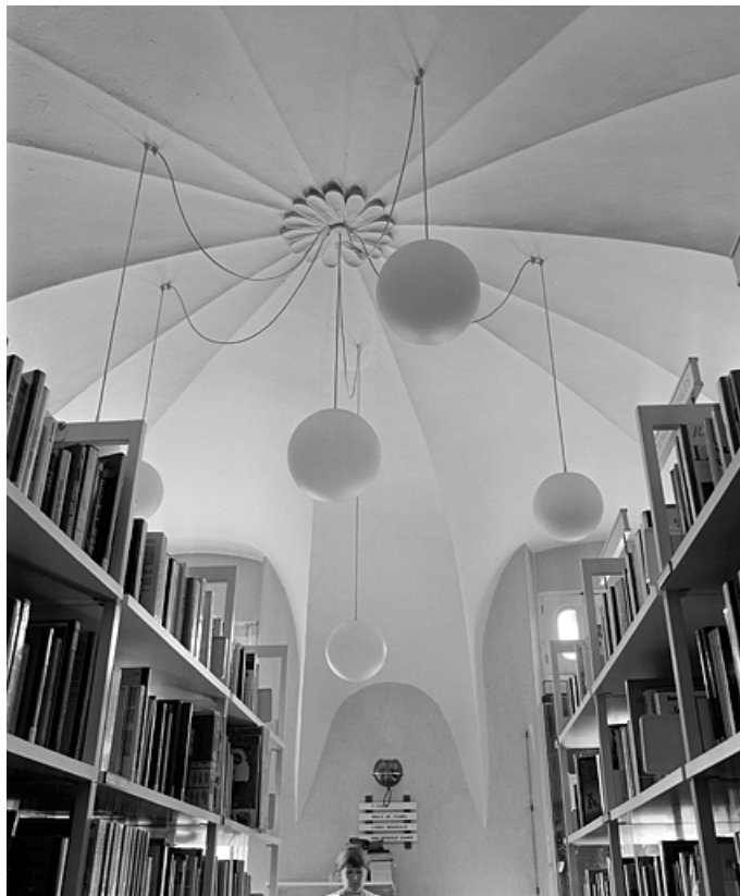
Bâtiments conventuels, voûte de l'ancienne cuisine.
