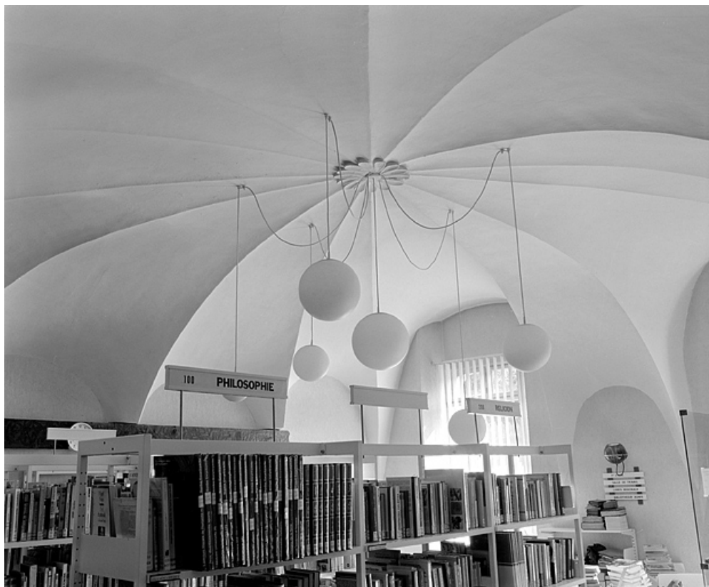
Bâtiments conventuels, voûte de l'ancienne cuisine.
