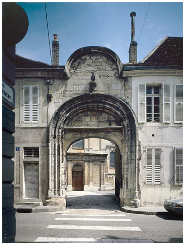
Portail d'entrée du couvent.
