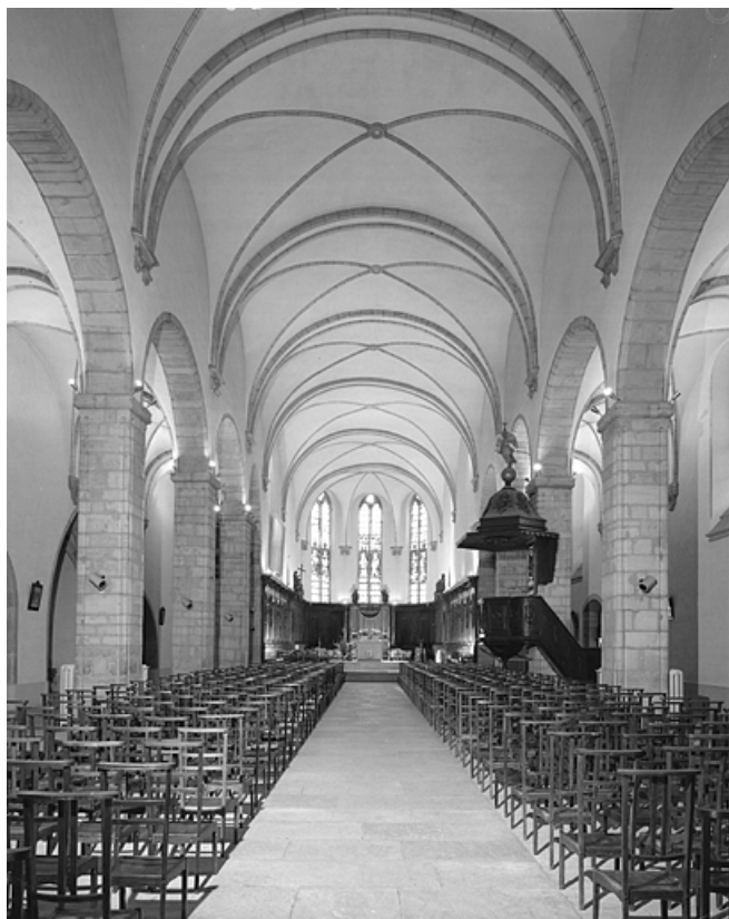
Eglise, vaisseau central, vue générale depuis l'ouest.
