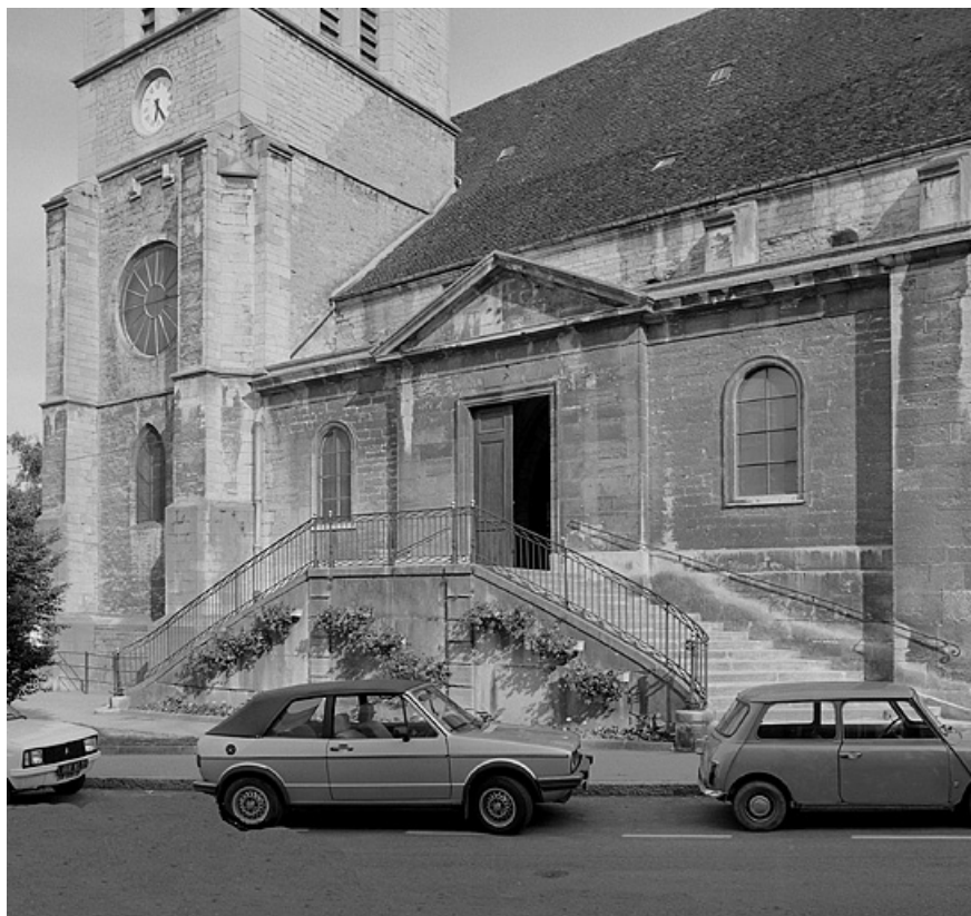
Eglise Saint-Désiré. Façade latérale nord, détail du portail et de son escalier extérieur. 39, Lons-le-Saunier, 1 rue de la Préfecture
