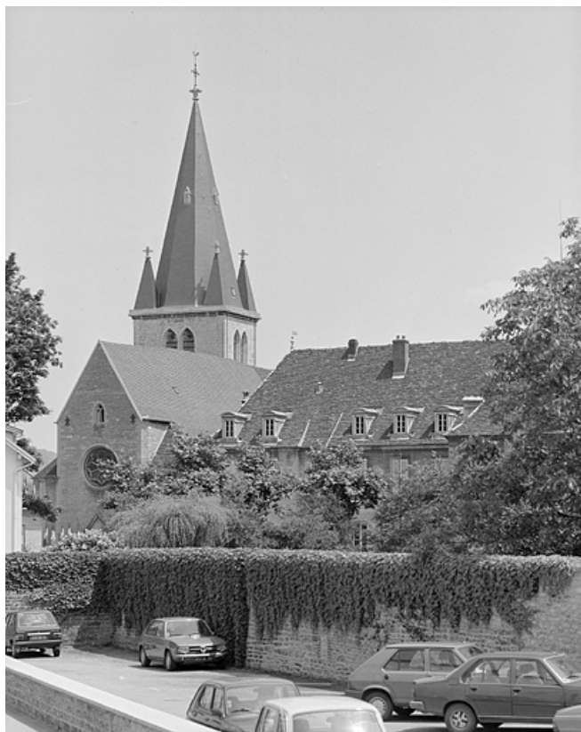
Eglise Saint-Désiré, vue générale depuis l'ouest.
