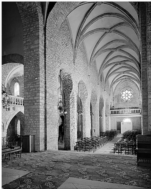
Eglise Saint-Désiré. Vaisseau central vu depuis le transept.
