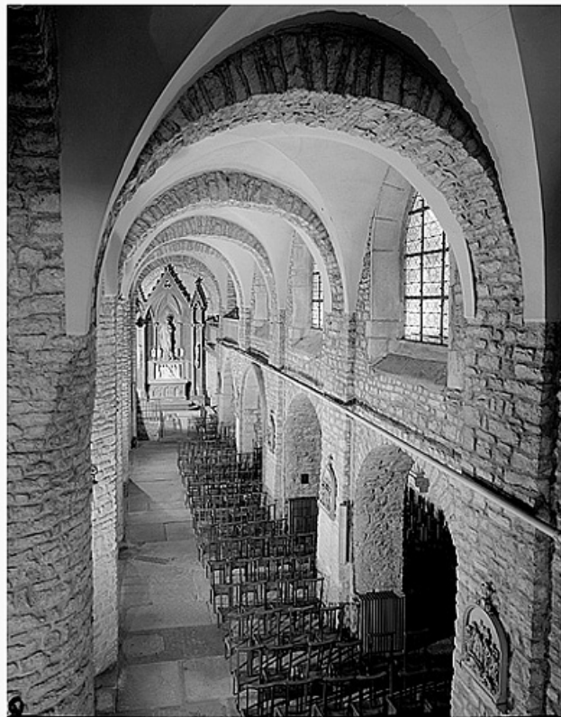
Eglise Saint-Désiré. Vaisseau latéral sud, vue générale. 39, Lons-le-Saunier, 1 rue de la Préfecture
