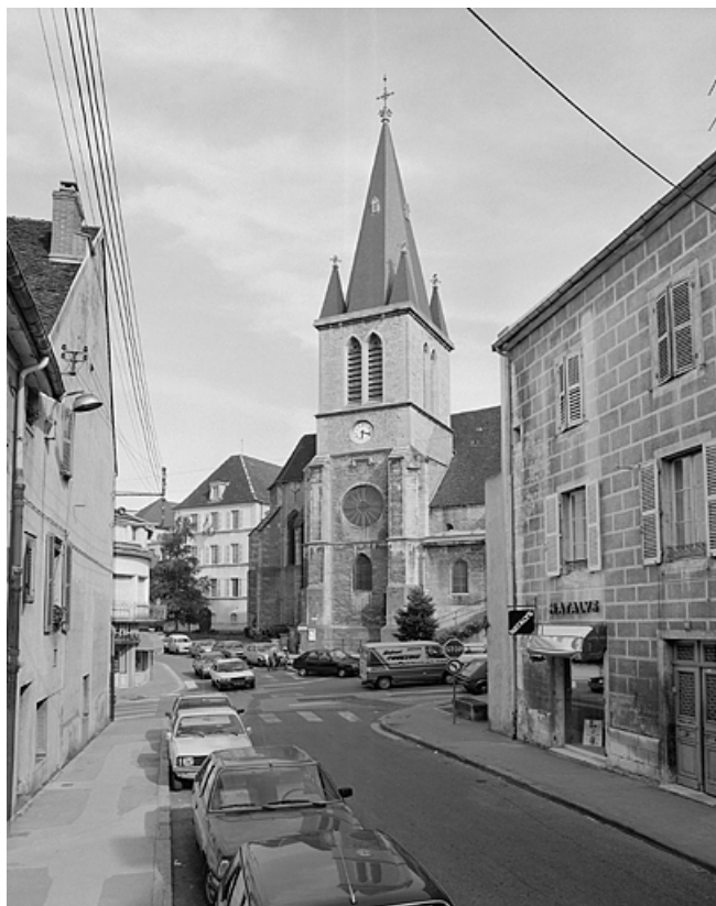
Eglise Saint-Désiré. Vue générale du clocher.
