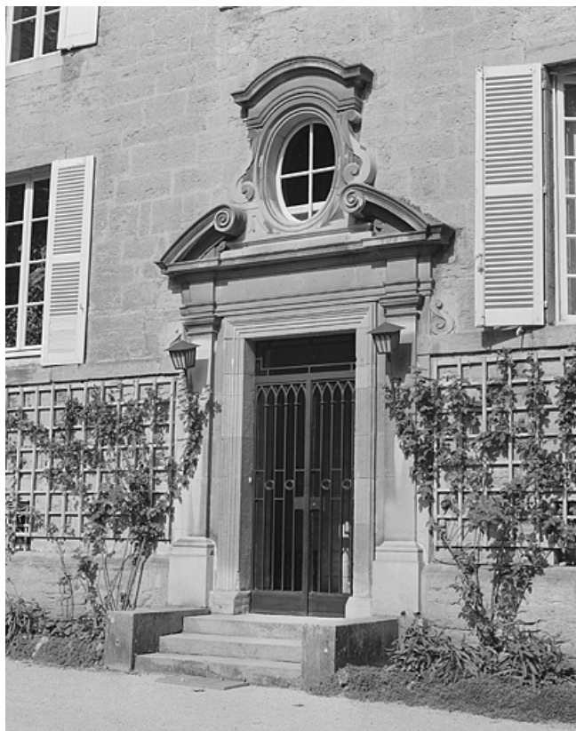
Bâtiments conventuels. Façade sur le parc : porte.
