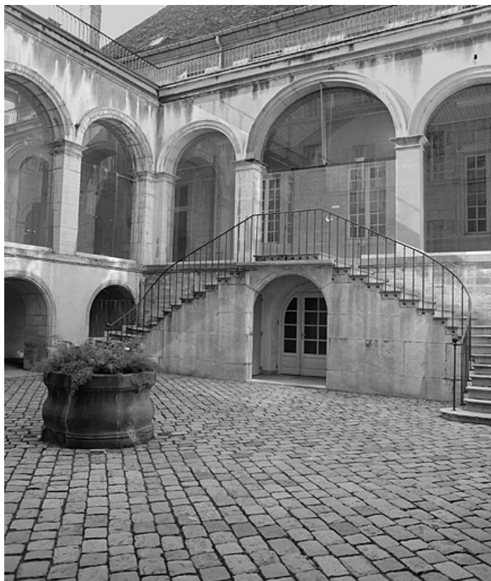
Cour intérieure : vue générale.
