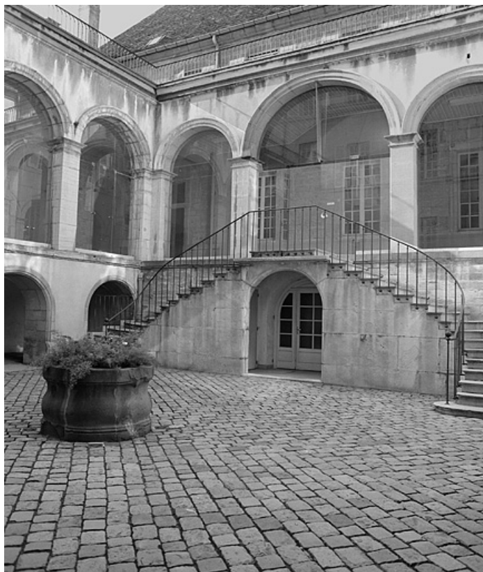
Cour intérieure : vue générale.
