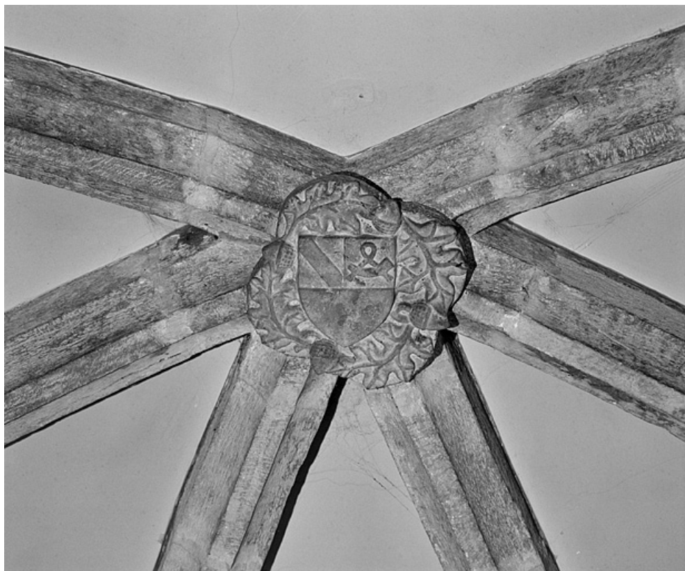
Eglise Saint-Désiré. Clef de voûte de l'abside.
