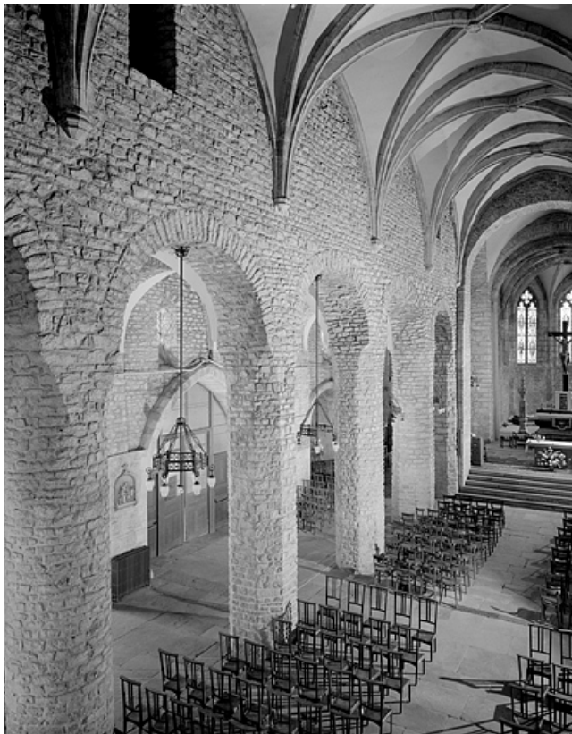
Eglise Saint-Désiré. Vaisseau central et vaisseau latéral nord, vue générale. 39, Lons-le-Saunier, 1 rue de la Préfecture
