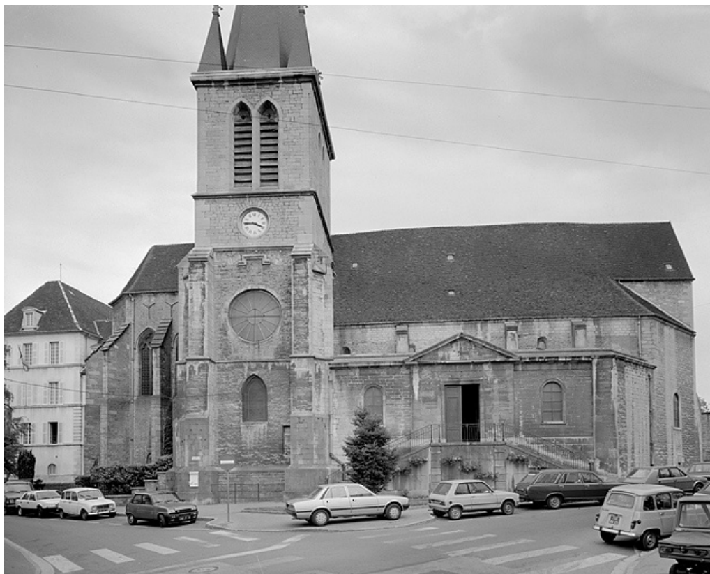
Eglise Saint-Désiré. Vue générale de la façade latérale nord.
