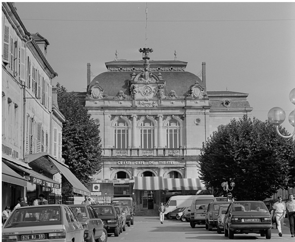
Façade antérieure, vue générale.
