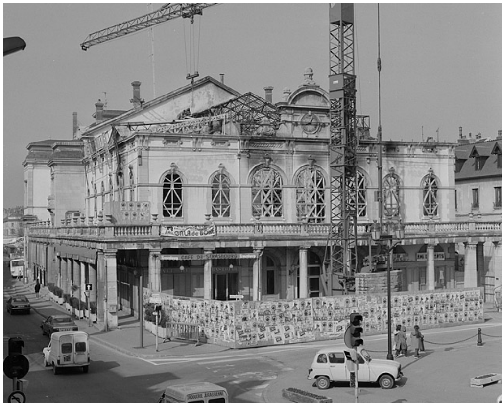
Façade postérieure (après l'incendie de 1983).
