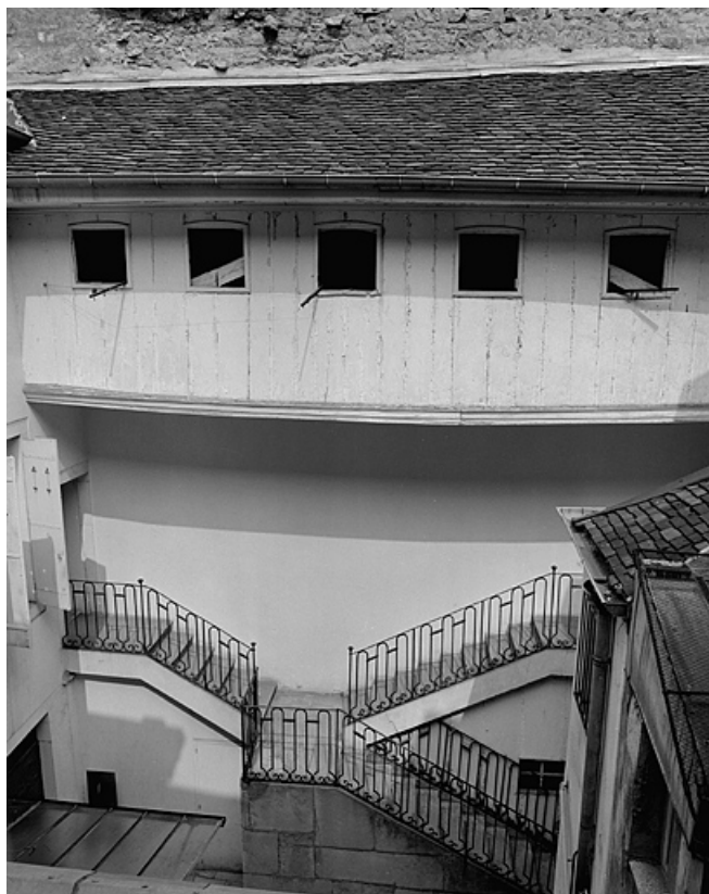
Maison, 48 rue du Commerce, escalier sur cour, vue d'ensemble. 39, Lons-le-Saunier
