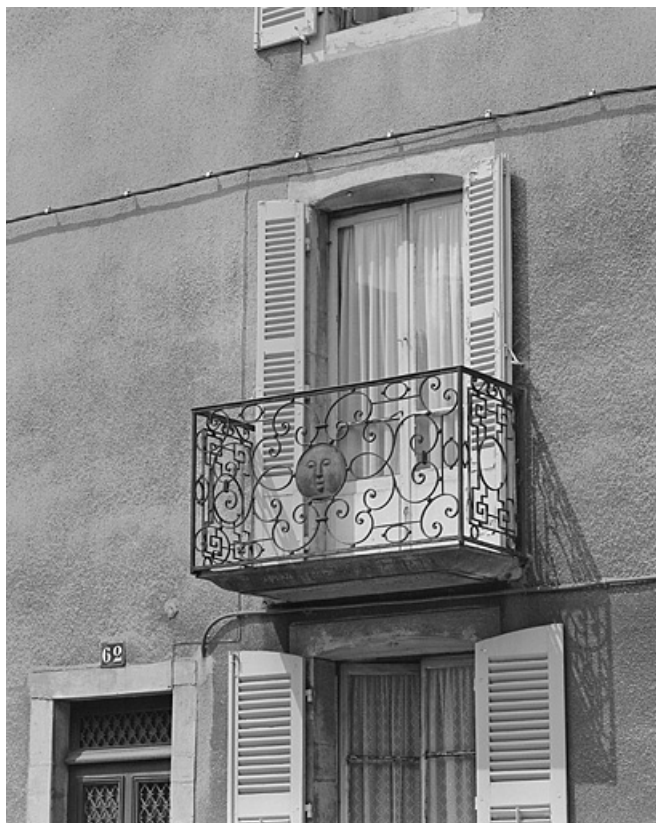
Maison, 62 rue des Salines, balcon avec ferronnerie. 39, Lons-le-Saunier
