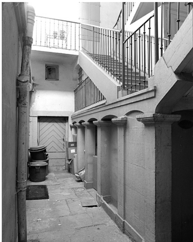
Maison, 58 rue du Commerce, escalier sur cour. 39, Lons-le-Saunier
