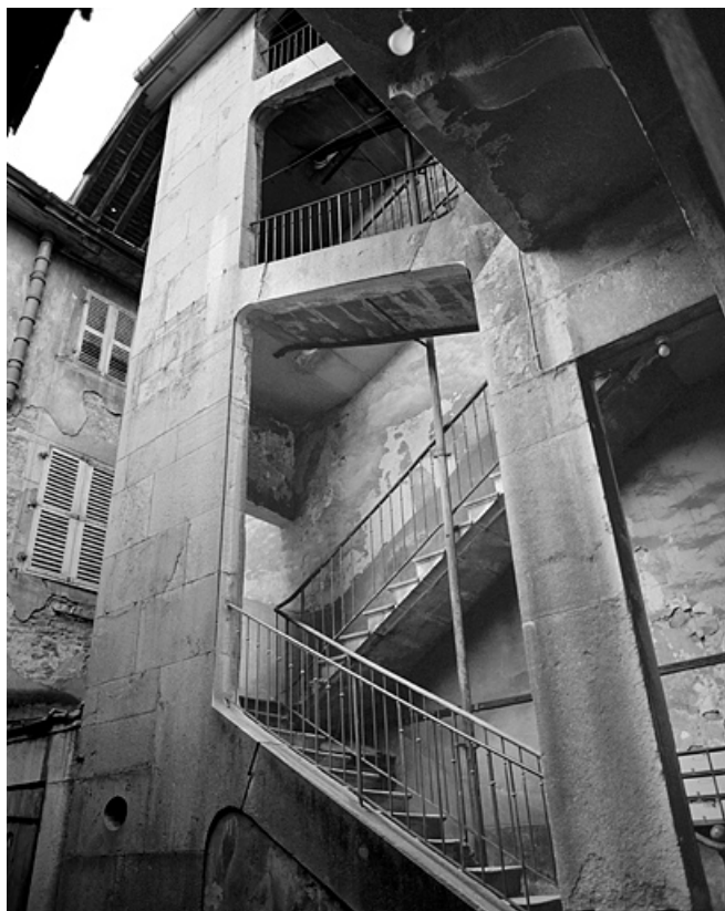
Maison, 16 rue Regard, escalier sur cour. 39, Lons-le-Saunier
