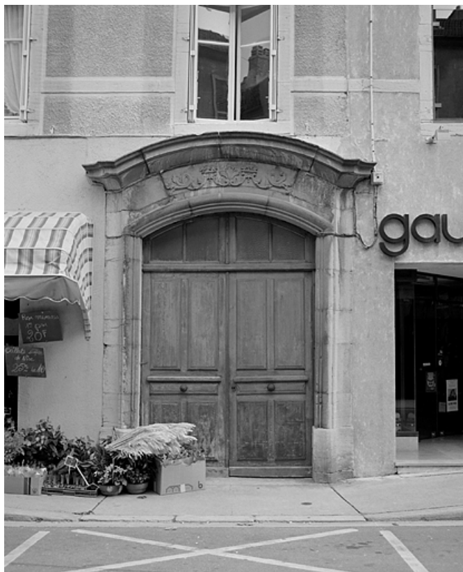
Maison, 15 rue Lafayette, porte cochère. 39, Lons-le-Saunier
