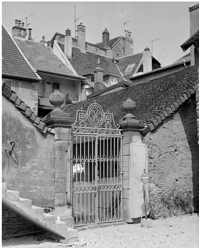
Maison, 5 rue Saint-Désiré, portail d'accès au jardin. 39, Lons-le-Saunier
