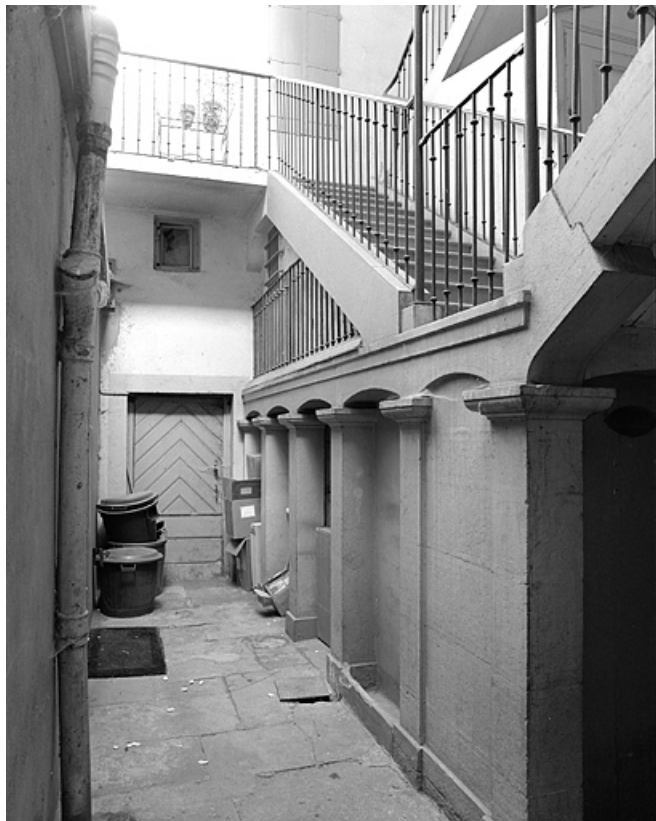
Maison, 58 rue du Commerce, escalier sur cour. 39, Lons-le-Saunier
