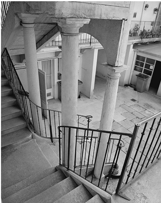
Maison, 74 rue Saint-Désiré, escalier sur cour, détail. 39, Lons-le-Saunier
