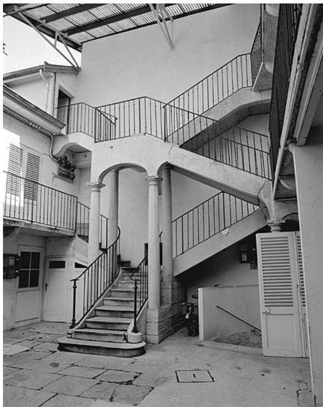
Maison, 74 rue Saint-Désiré, escalier sur cour. 39, Lons-le-Saunier
