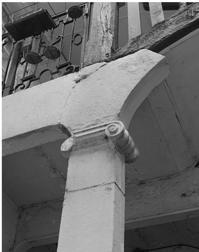
Maison, 48 rue du Commerce, escalier sur cour, détail d'un pilier. 39, Lons-le-Saunier
