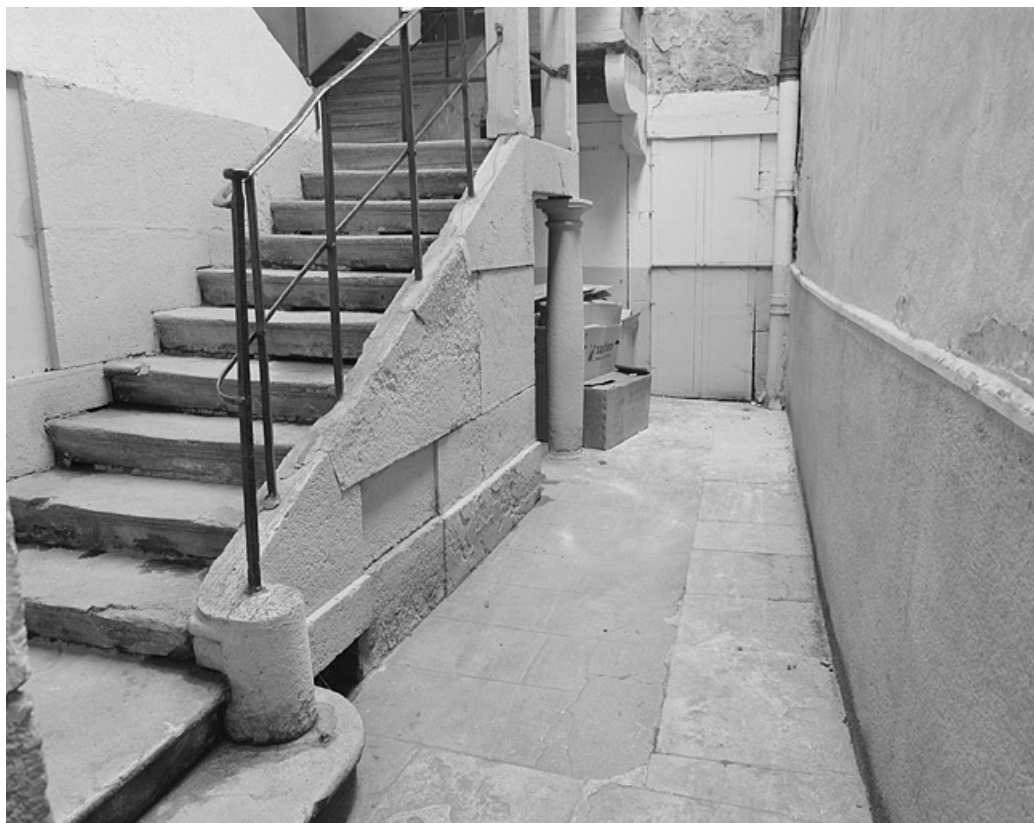
Maison, 26 rue du Commerce, escalier sur cour. 39, Lons-le-Saunier
