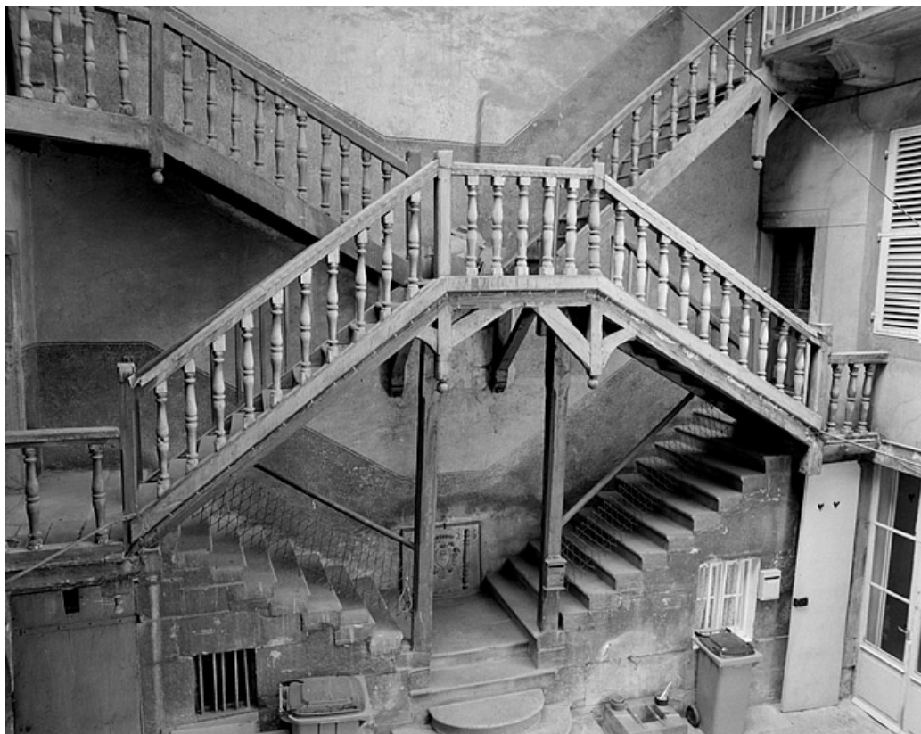
Maison, 17 rue Saint-Désiré, escalier sur cour. 39, Lons-le-Saunier
