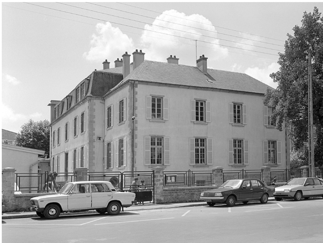
Ecole, 1 avenue Aristide Briand, façade gauche et façade postérieure. 39, Lons-le-Saunier
