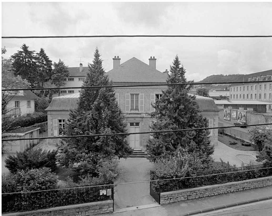
Ecole, 19 rue des Ecoles, façade antérieure. 39, Lons-le-Saunier
