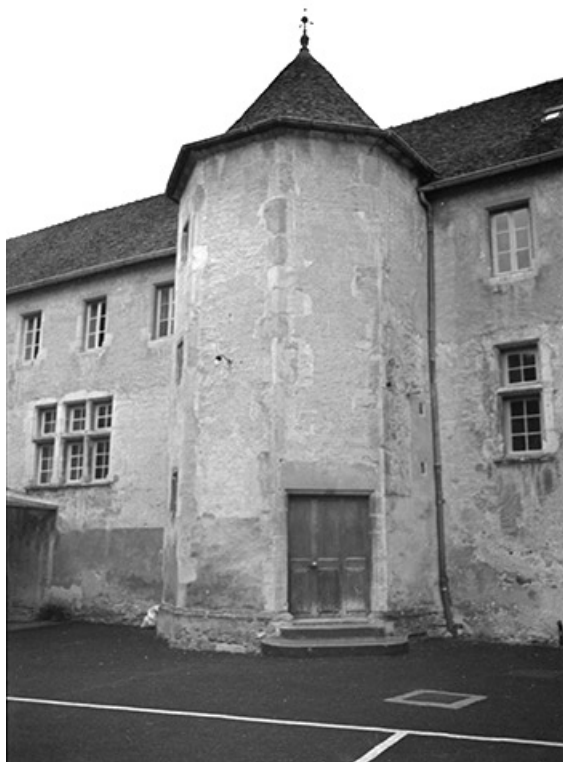
Tourelle d'escalier dans la cour.
