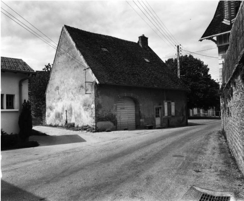
Façades antérieure et latérale gauche.
