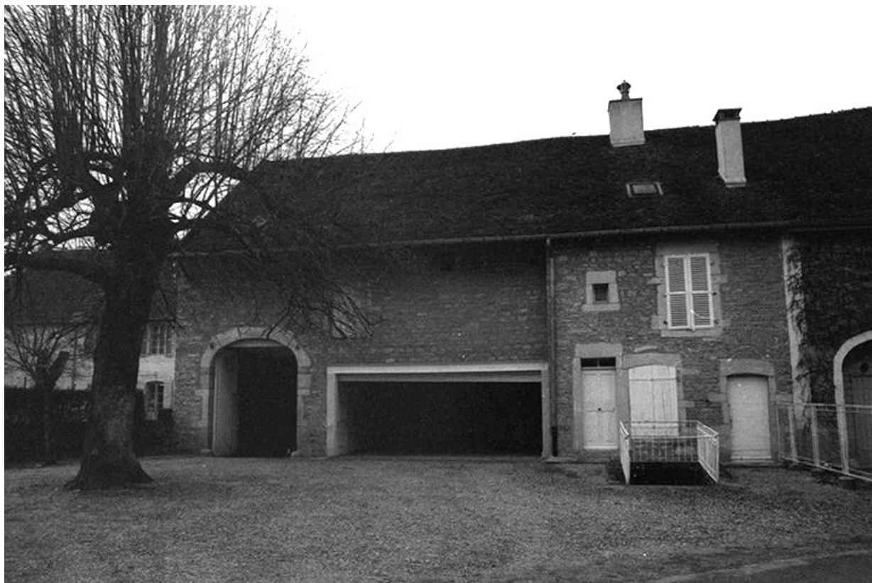
Maison de vigneron : façade antérieure. 39, Voiteur
