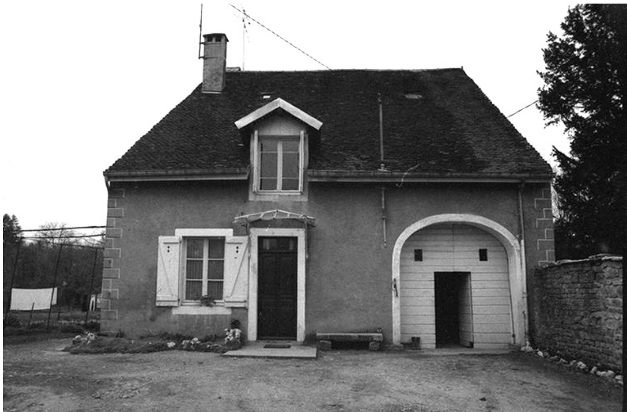
Maison cadastrée 1961 AH 56, située rue du Presbytère : façade antérieure. 39, Voiteur
