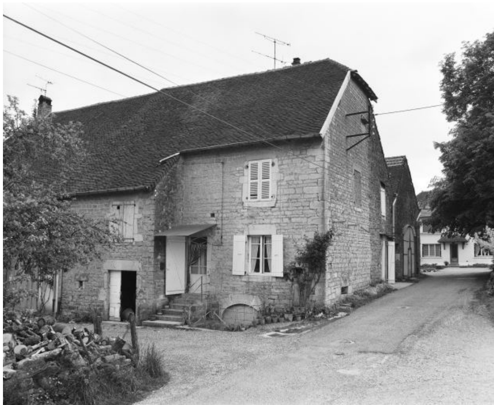
Façade antérieure et latérale droite.
