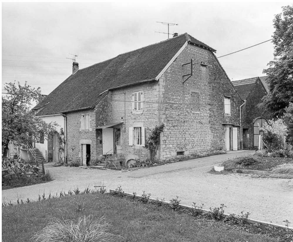
Façades antérieure et latérale droite.
