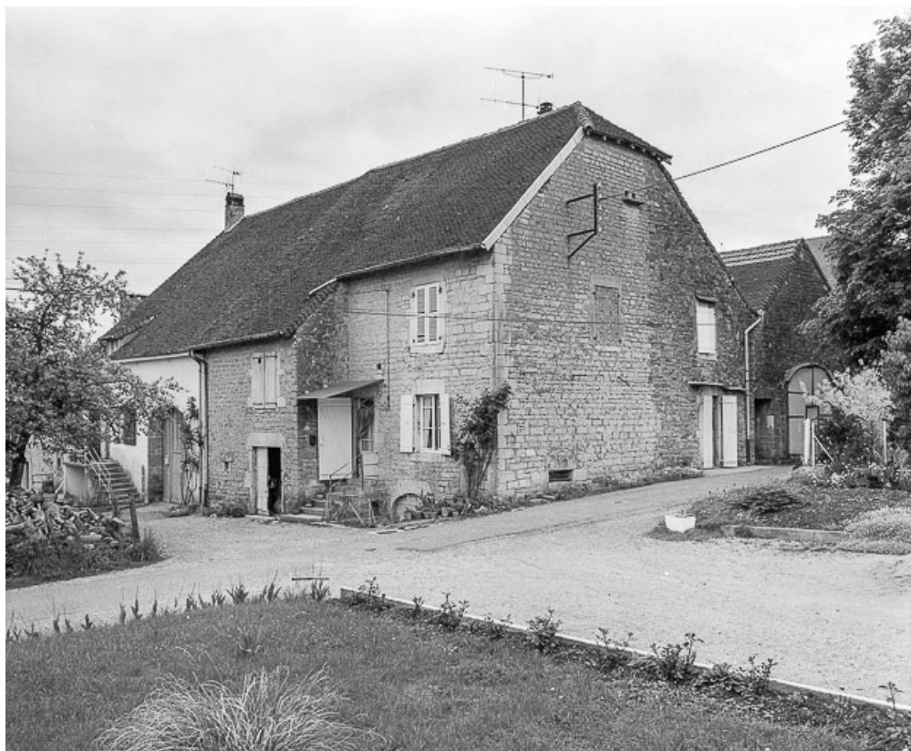
Façades antérieure et latérale droite.
