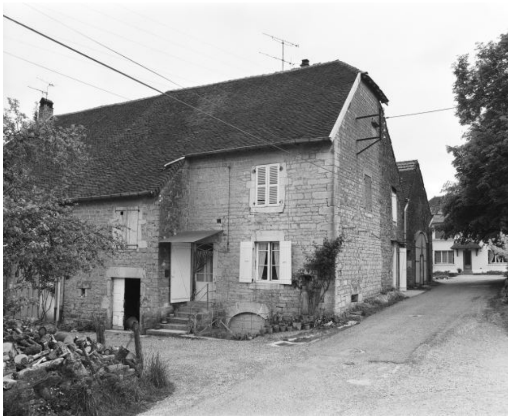
Façade antérieure et latérale droite.
