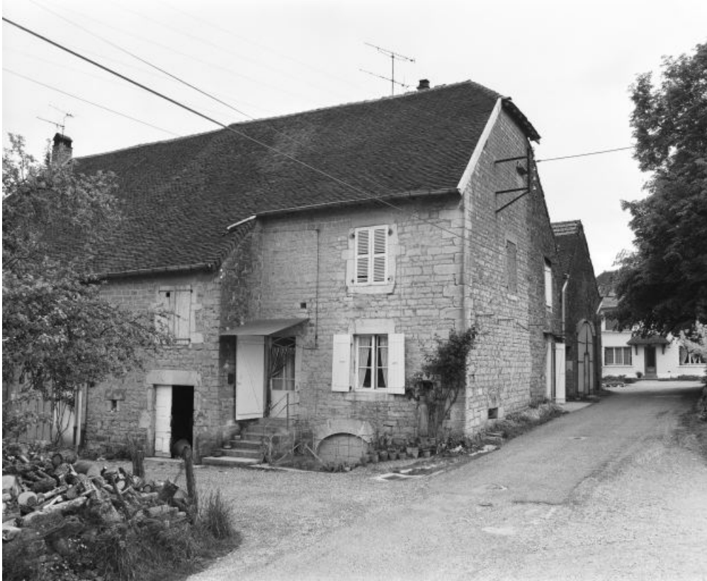
Façade antérieure et latérale droite.
