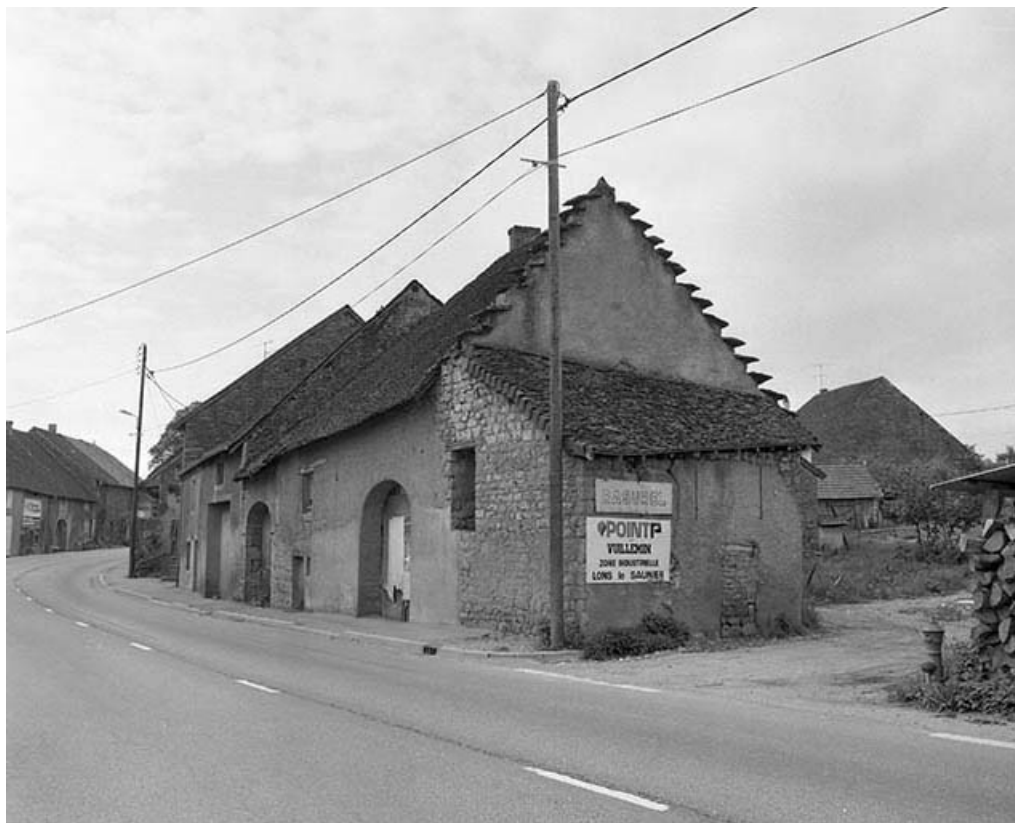
Façade antérieure vue de trois quarts droit. 39, Plainoiseau
