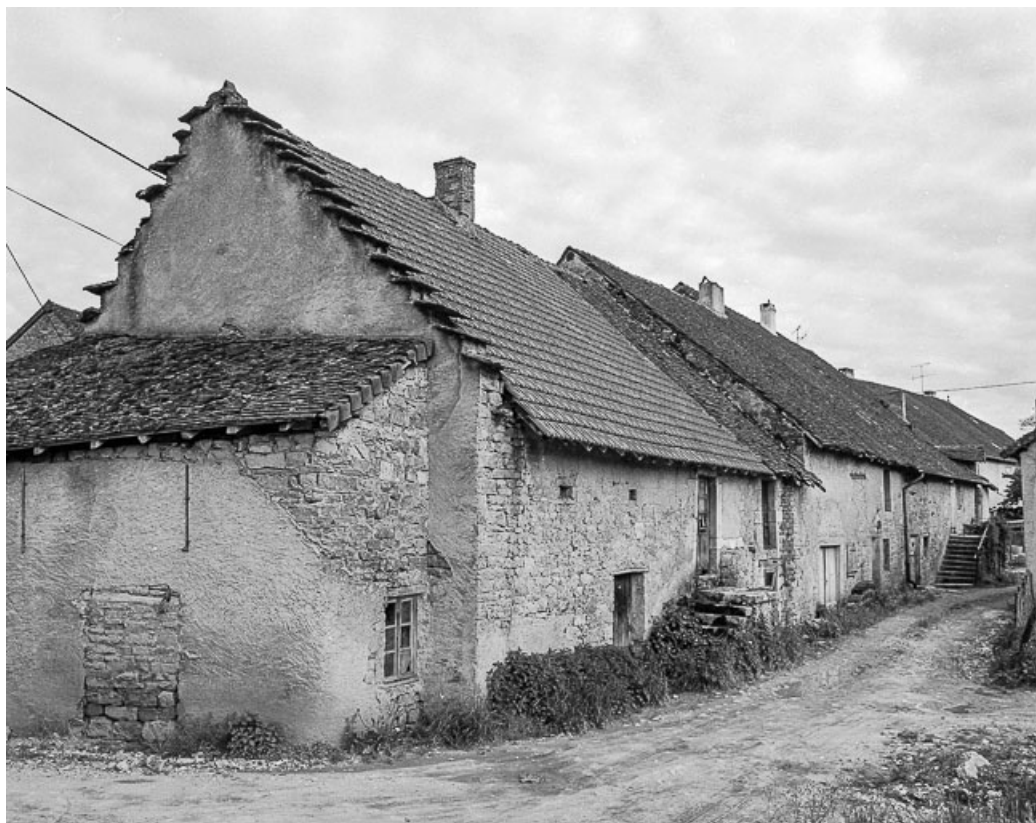
Façade postérieure vue de trois quarts gauche.
