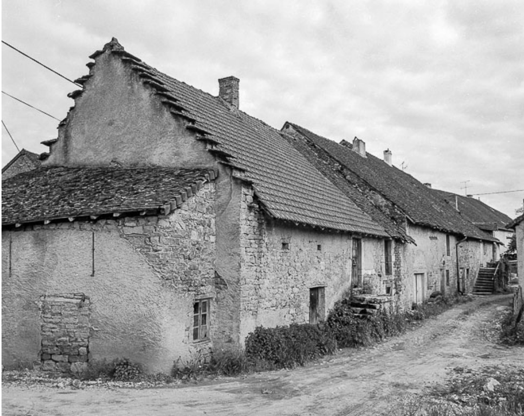
Façade postérieure vue de trois quarts gauche.
