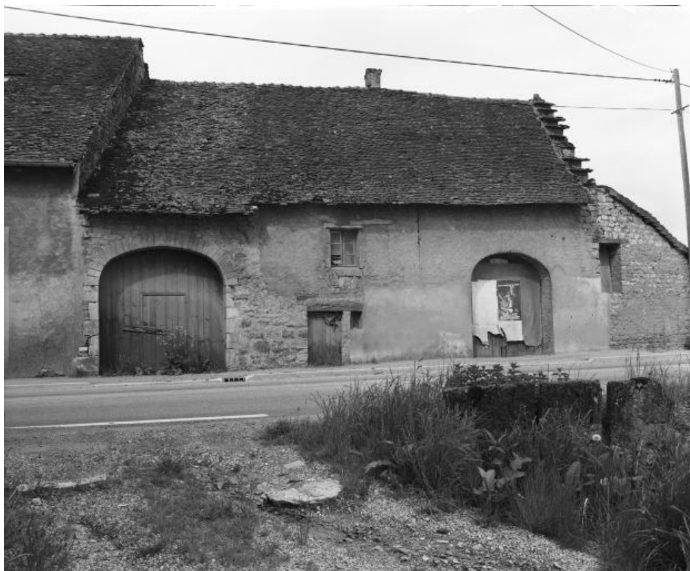
Façade antérieure vue de face.
