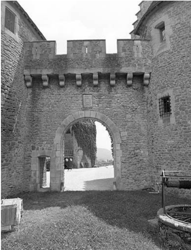
Portail nord : vue de face.
