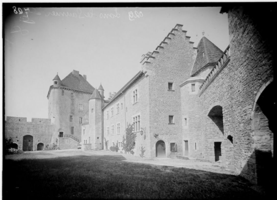
Vue des bâtiments sur la cour intérieure.
