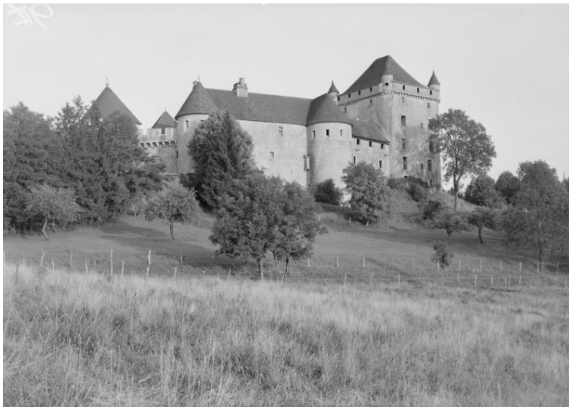
Façade ouest : vue d'ensemble.
