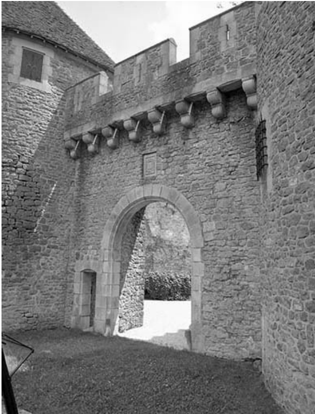
Portail nord : vue de trois quarts.
