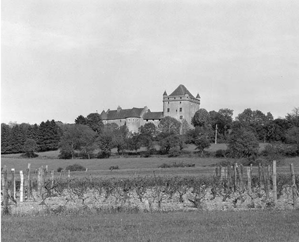
Façade ouest : vue éloignée.
