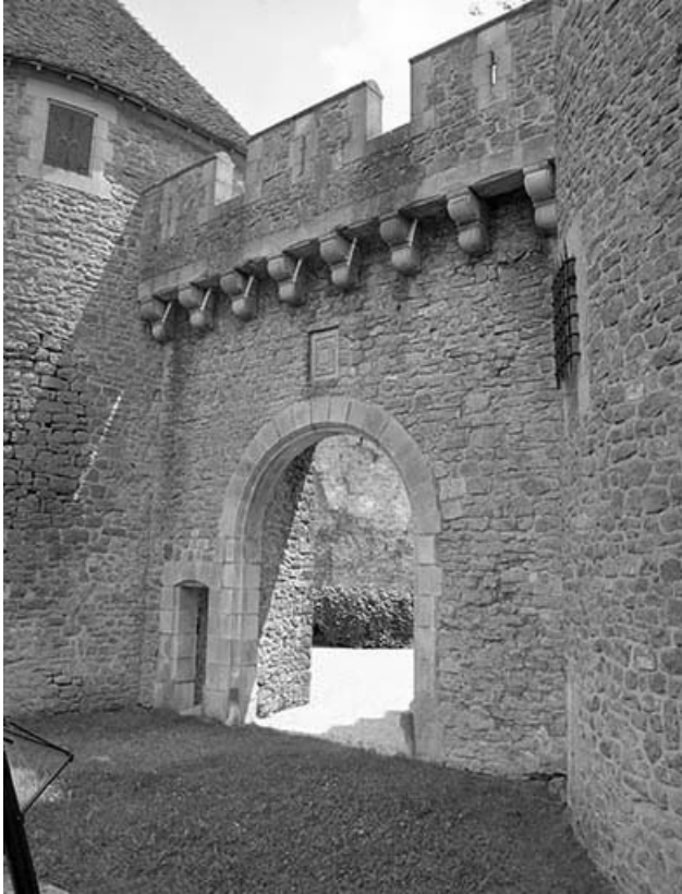
Portail nord : vue de trois quarts.
