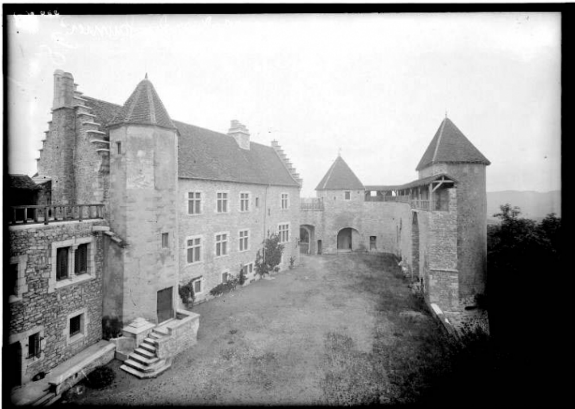
Vue des bâtiments autour de la cour intérieure.
