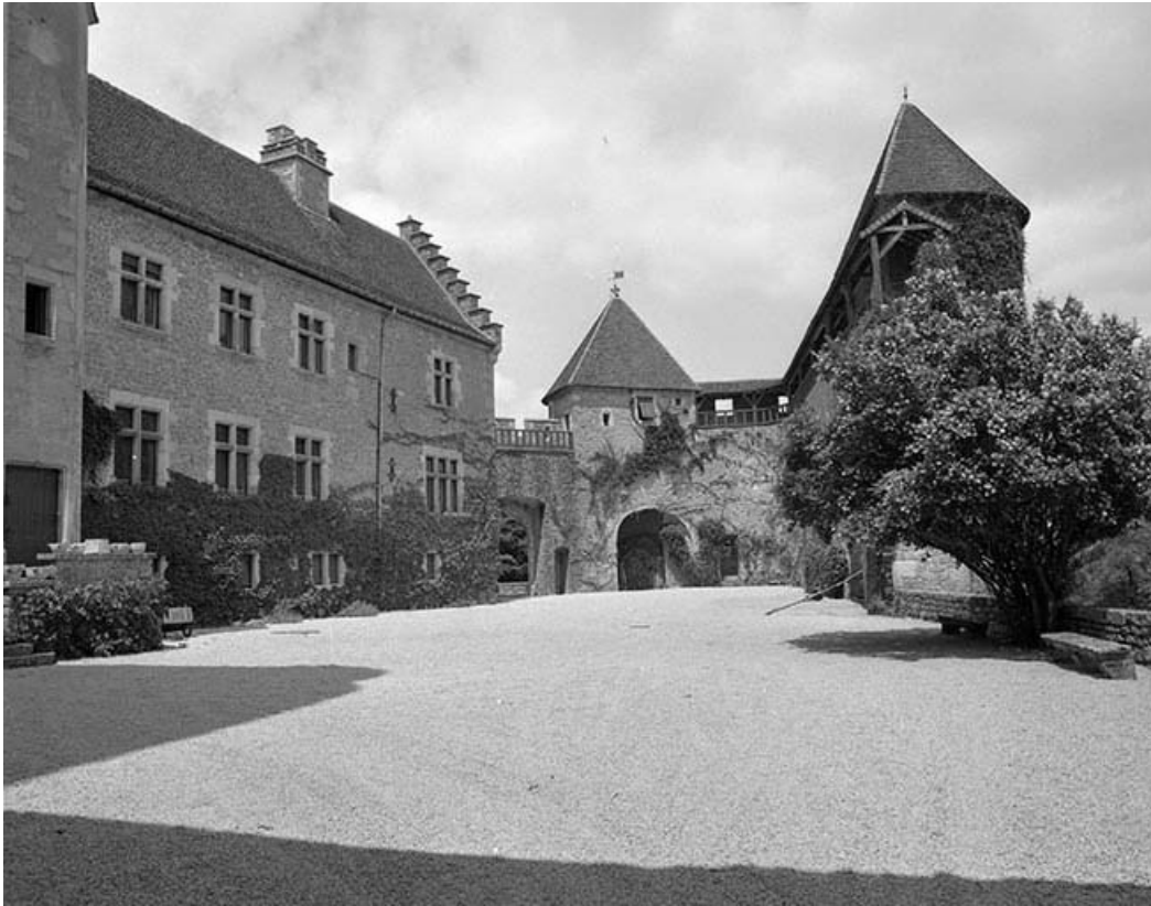
Vue générale de la cour intérieure.
