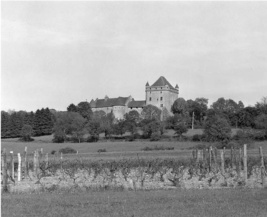
Façade ouest : vue éloignée.
