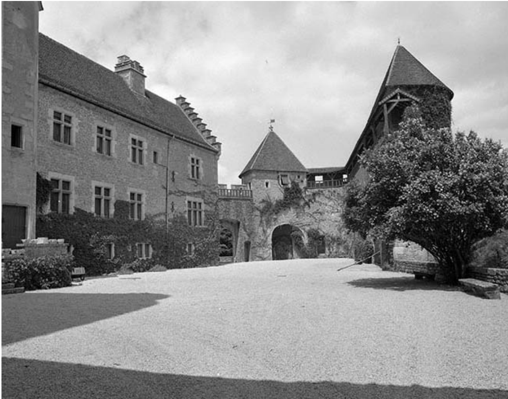
Vue générale de la cour intérieure.
