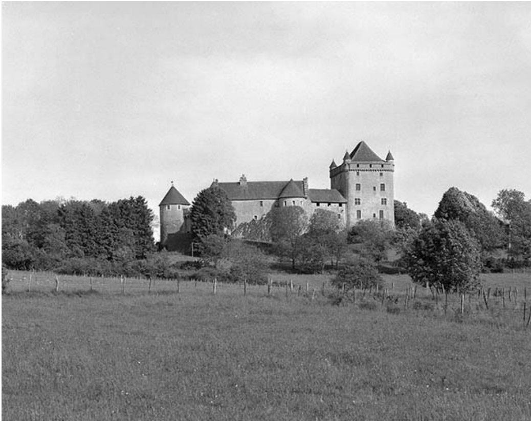
Façade ouest : vue éloignée.
