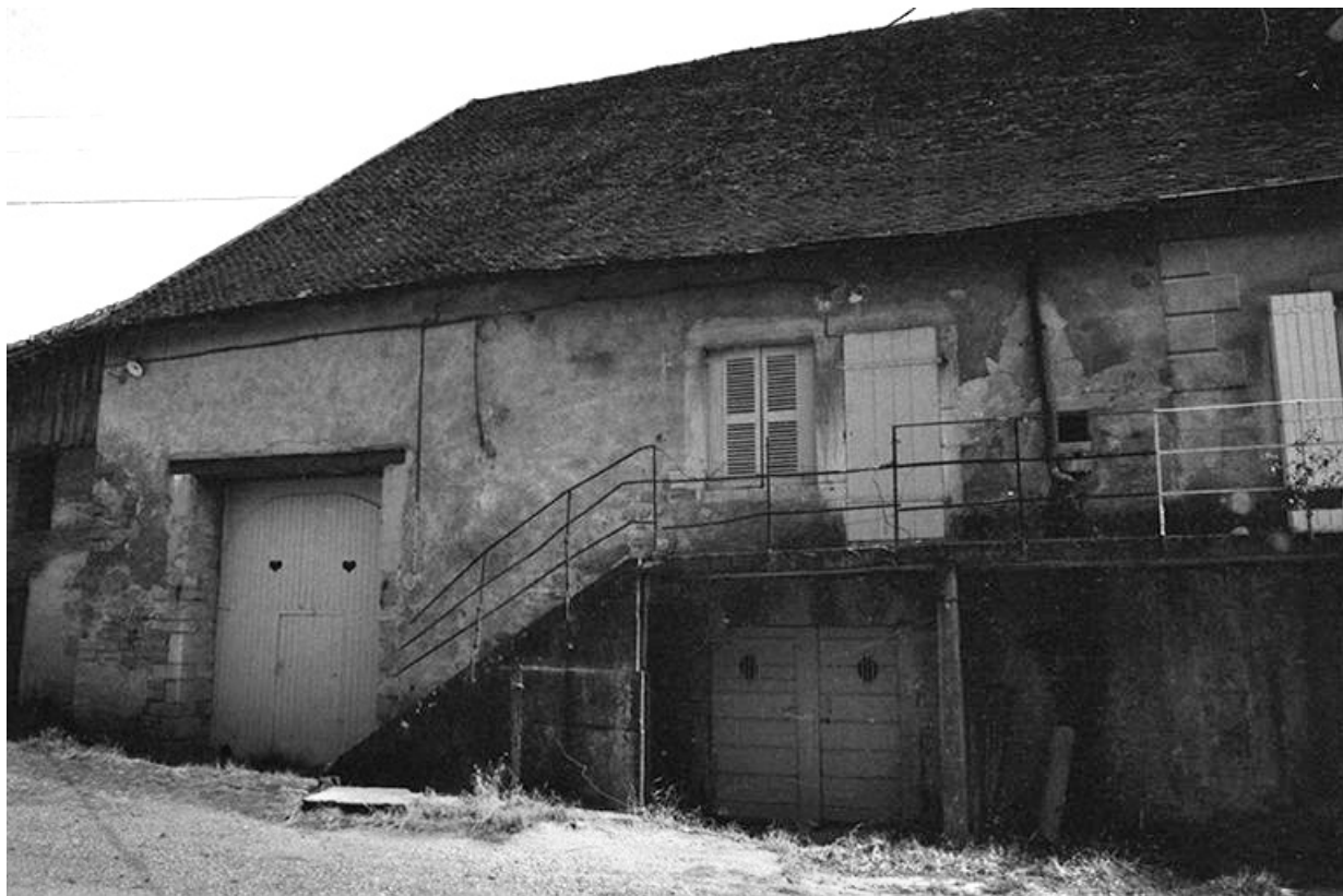
Ferme cadastrée 1951 A3 272, 275 située le long du chemin départemental n° 208 du Pin à Lons-le-Saunier : façade antérieure. 39, Le Pin
