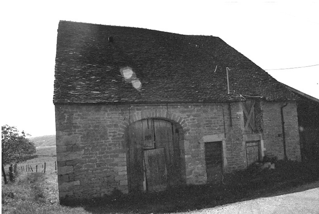
Ferme cadastrée 1951 A3 242, située le long du chemin vicinal n° 3 du Pin à Montain : façade antérieure. 39, Le Pin
