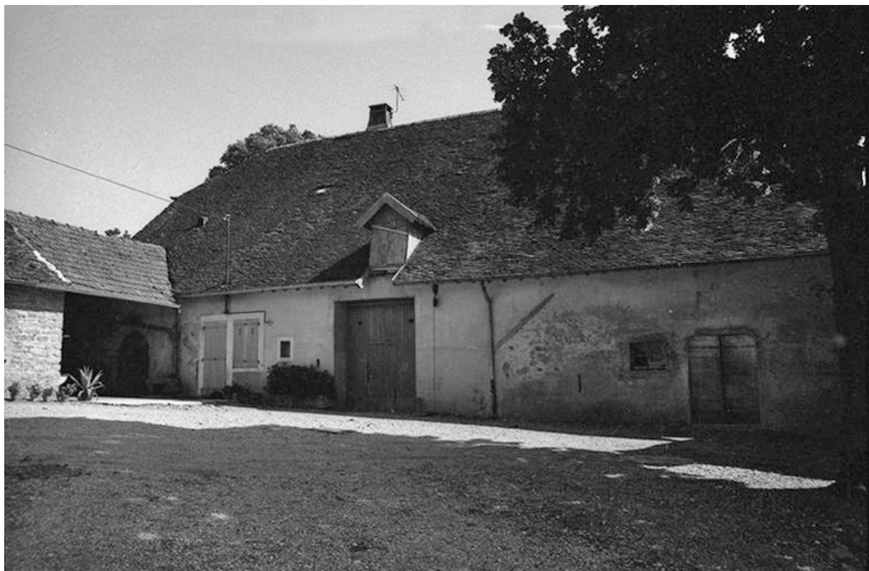
Ferme cadastrée 1951 A3 313 situées le long du chemin départemental n° 208 du Pin à Lons-le-Saunier : façade antérieure. 39, Le Pin
