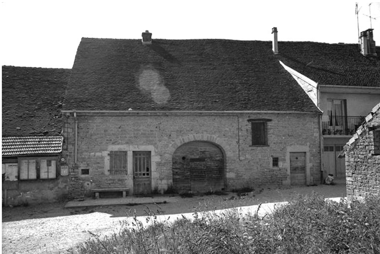
Ferme cadastrée 1951 A3 266 situées le long du chemin départemental n° 208 du Pin à Lons-le-Saunier : façade antérieure.
