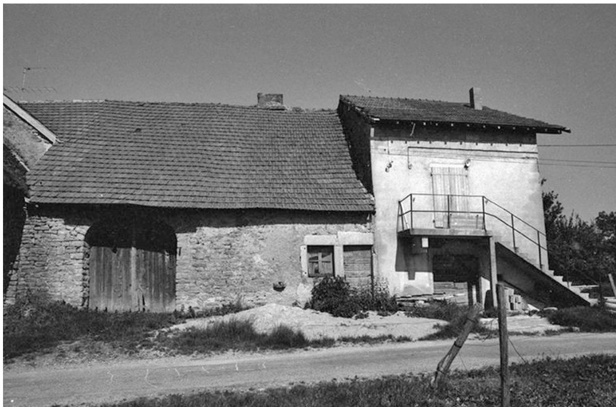
Ferme cadastrée 1951 A3 452-453, située le long du chemin vicinal n° 3 du Pin à Montain : façade antérieure. 39, Le Pin
