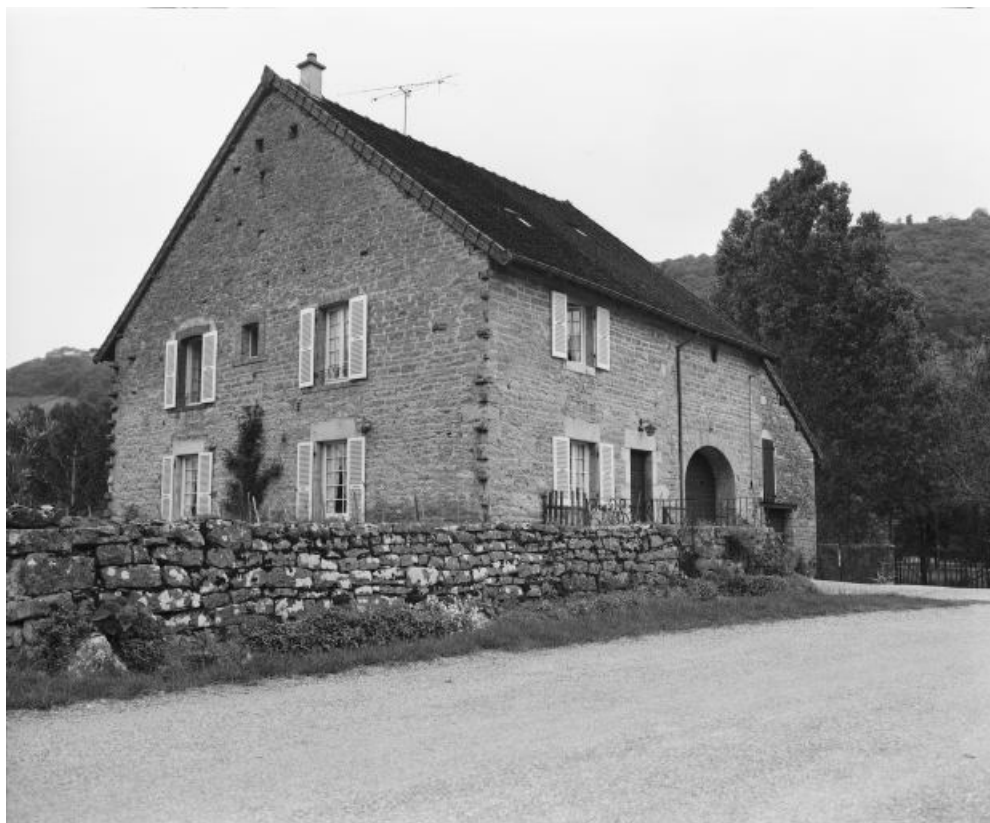
Façades antérieure et latérale droite en 1981.
