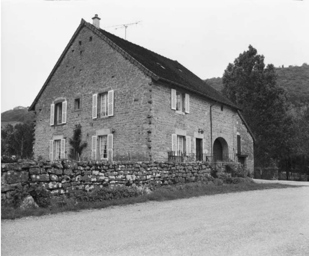
Façades antérieure et latérale droite en 1981.
