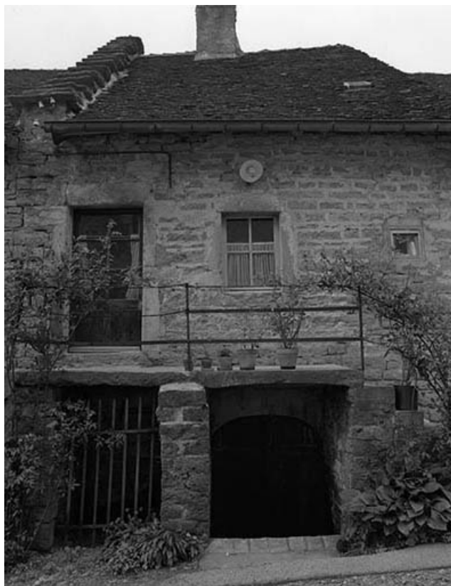
Façade antérieure : habitation.
