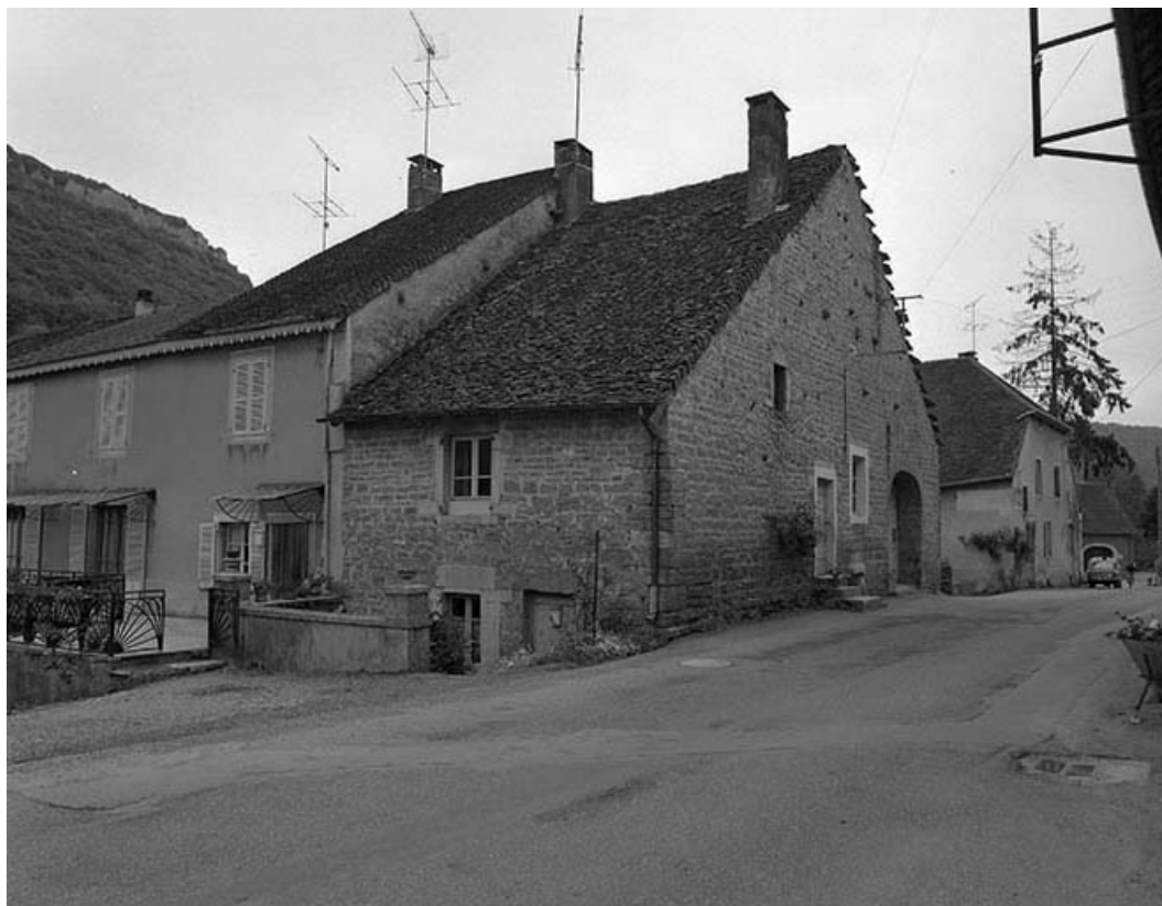
Façade antérieure et façade droite vues depuis la rue.
