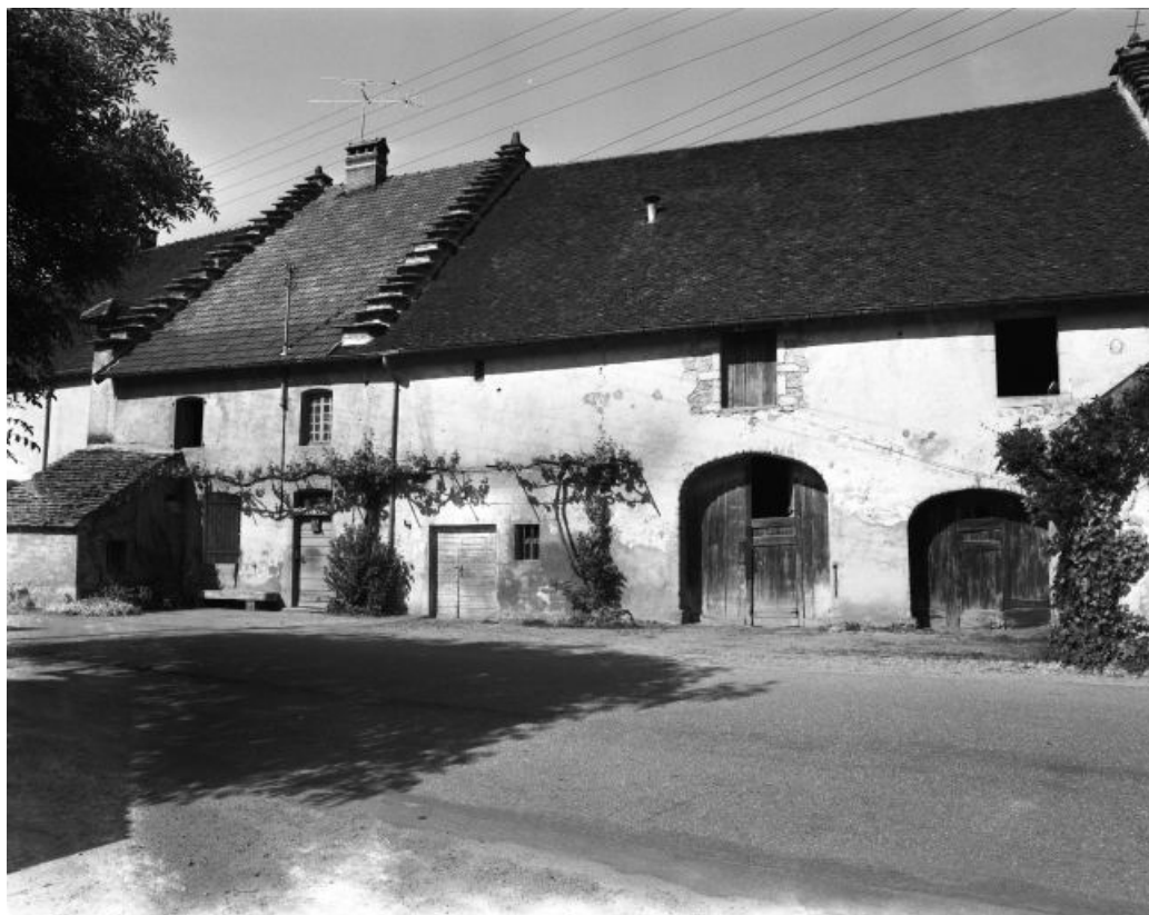
Façade antérieure en 1981.
