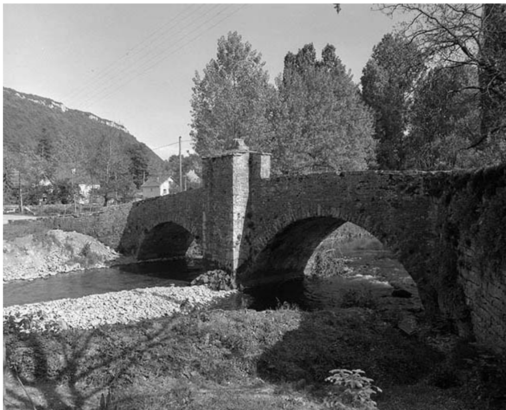
Face aval de trois quarts droit.
