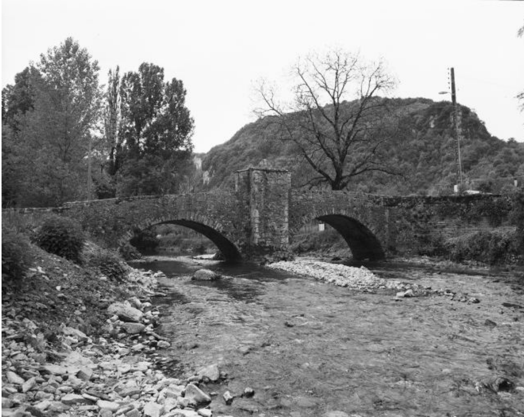
Face aval vue de trois quarts.
