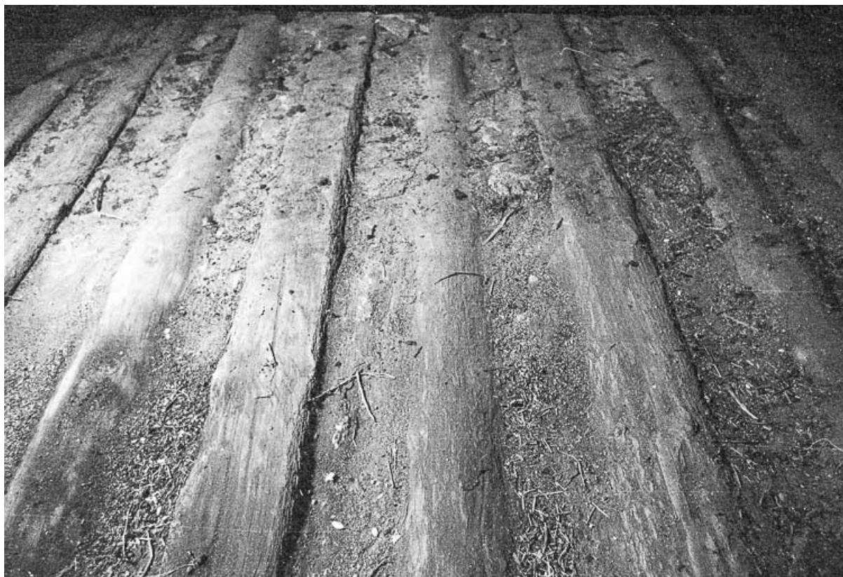
Ferme cadastrée 1965 AD : détail du plafond.
