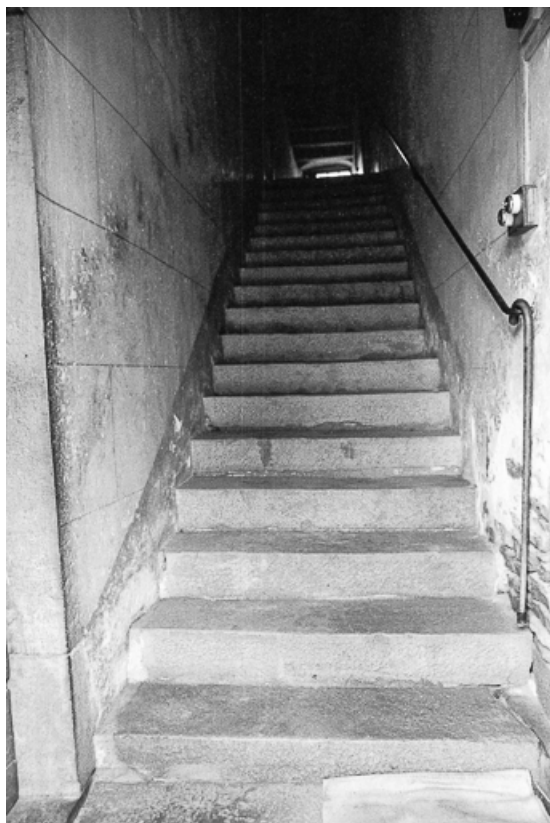
Ferme cadastrée 1965 AD : escalier intérieur. 39, Nevy-sur-Seille
