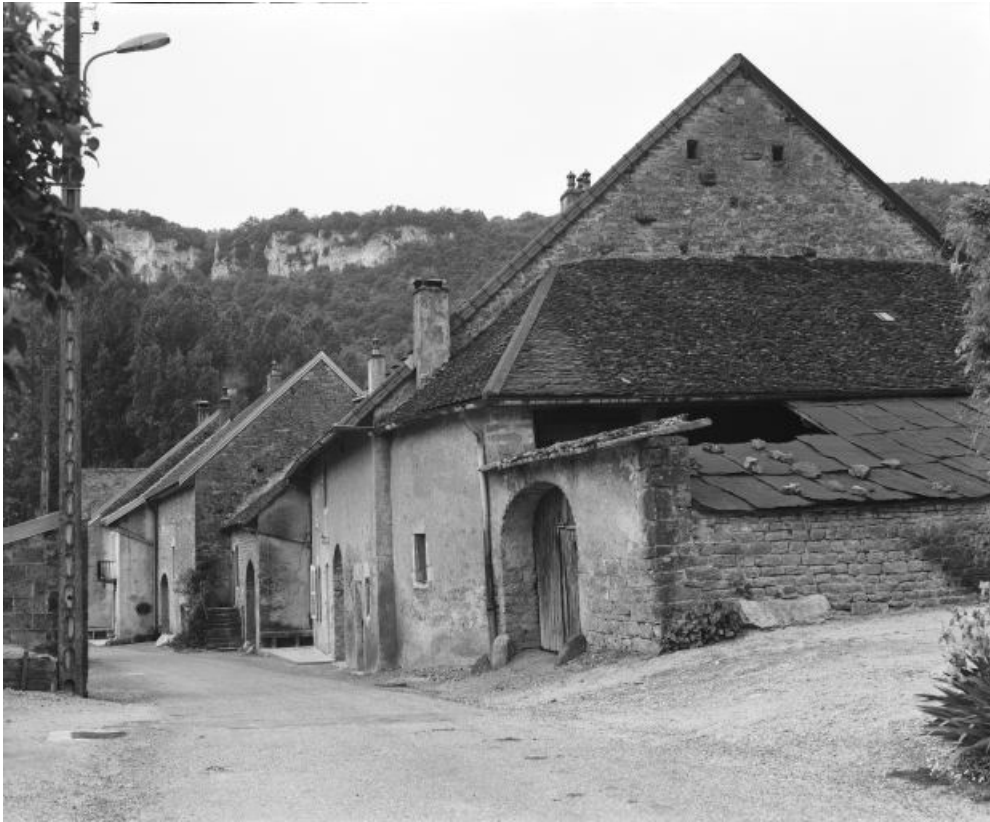
Vue générale de trois-quarts droit. 39, Nevy-sur-Seille
