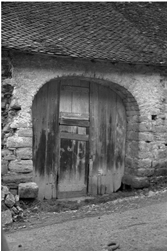
Ferme cadastrée 1965 AD : porte de grange. 39, Nevy-sur-Seille
