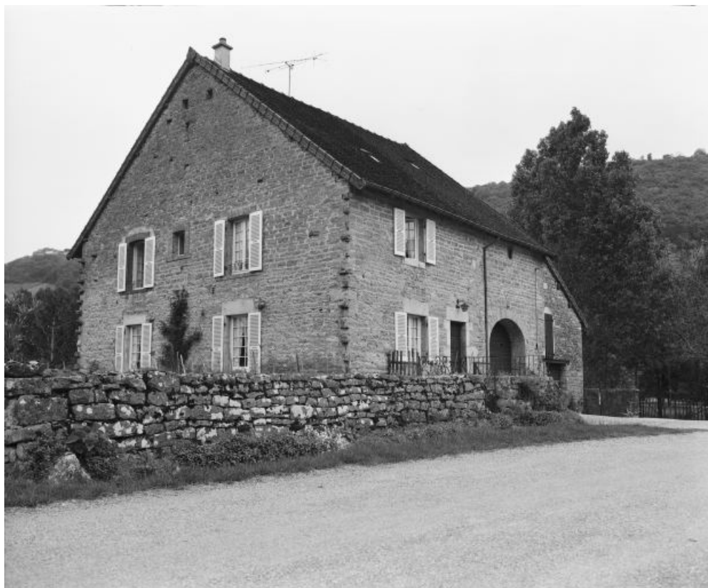
Façades antérieure et latérale droite en 1981.
