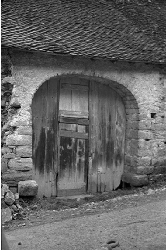
Ferme cadastrée 1965 AD : porte de grange. 39, Nevy-sur-Seille
