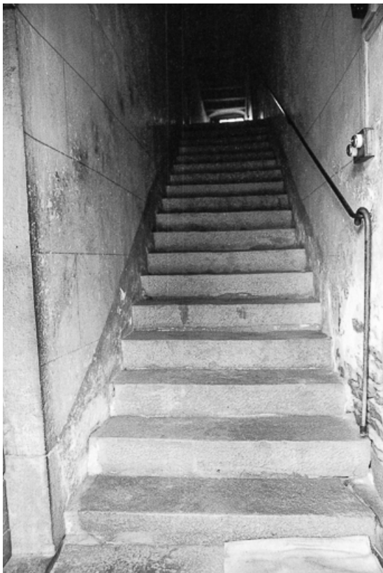
Ferme cadastrée 1965 AD : escalier intérieur. 39, Nevy-sur-Seille
