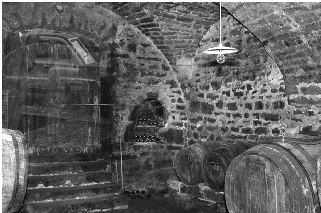
Ferme cadastrée 1965 AD : la cave
