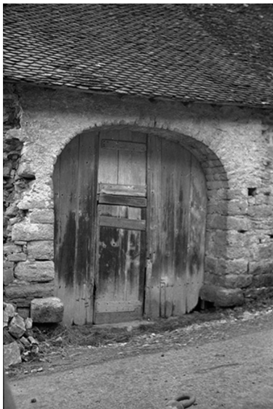
Ferme cadastrée 1965 AD : porte de grange. 39, Nevy-sur-Seille
