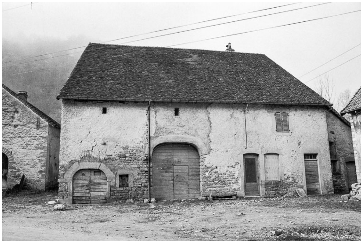
Ferme cadastrée 1965 AD 397, située chemin de Billin : façade antérieure. 39, Nevy-sur-Seille
