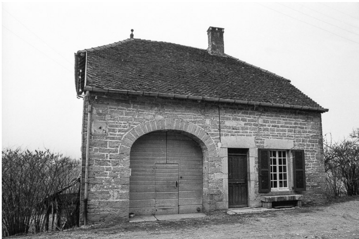
Ferme cadastrée 1965 AD 119 : façade antérieure.
