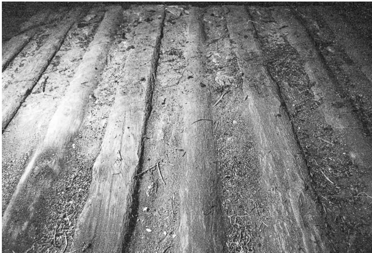
Ferme cadastrée 1965 AD : détail du plafond.
