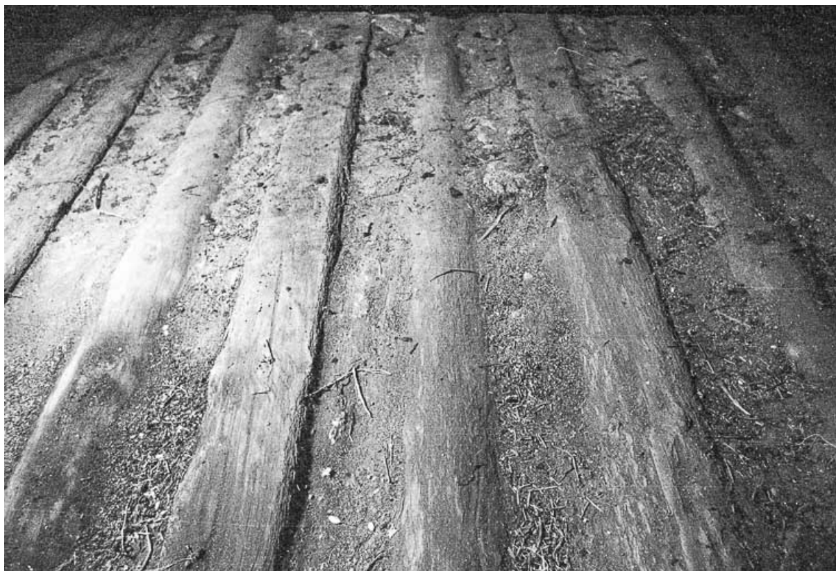
Ferme cadastrée 1965 AD : détail du plafond.
