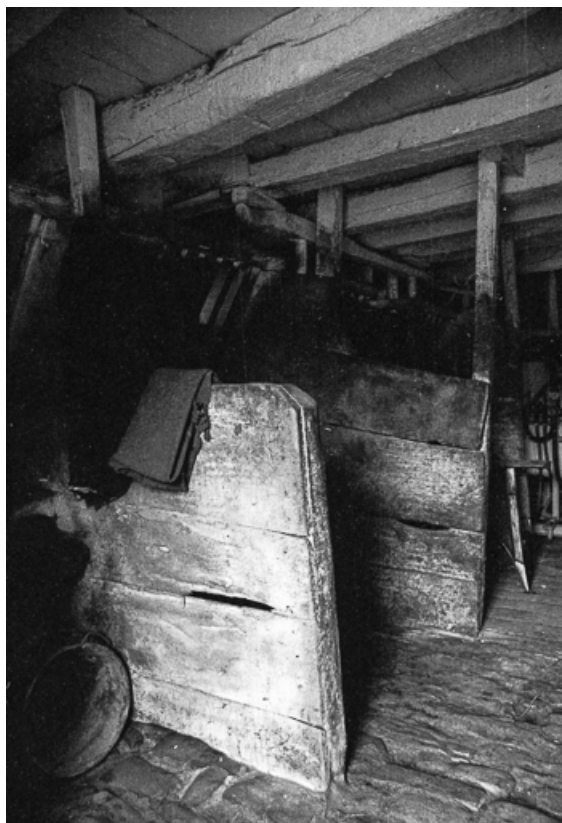
Ferme cadastrée 1965 AD : écurie, stalles des chevaux. 39, Nevy-sur-Seille
