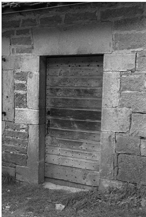
Ferme cadastrée 1965 AD : porte extérieure.
