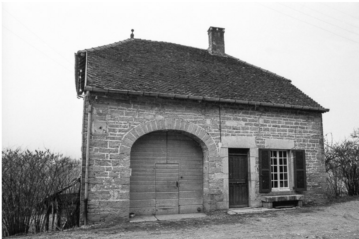
Ferme cadastrée 1965 AD 119 : façade antérieure.
