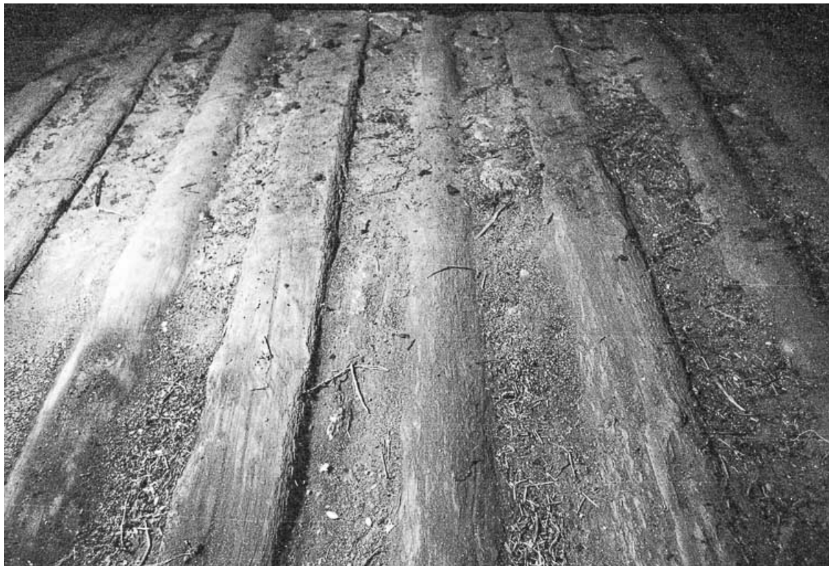
Ferme cadastrée 1965 AD : détail du plafond.
