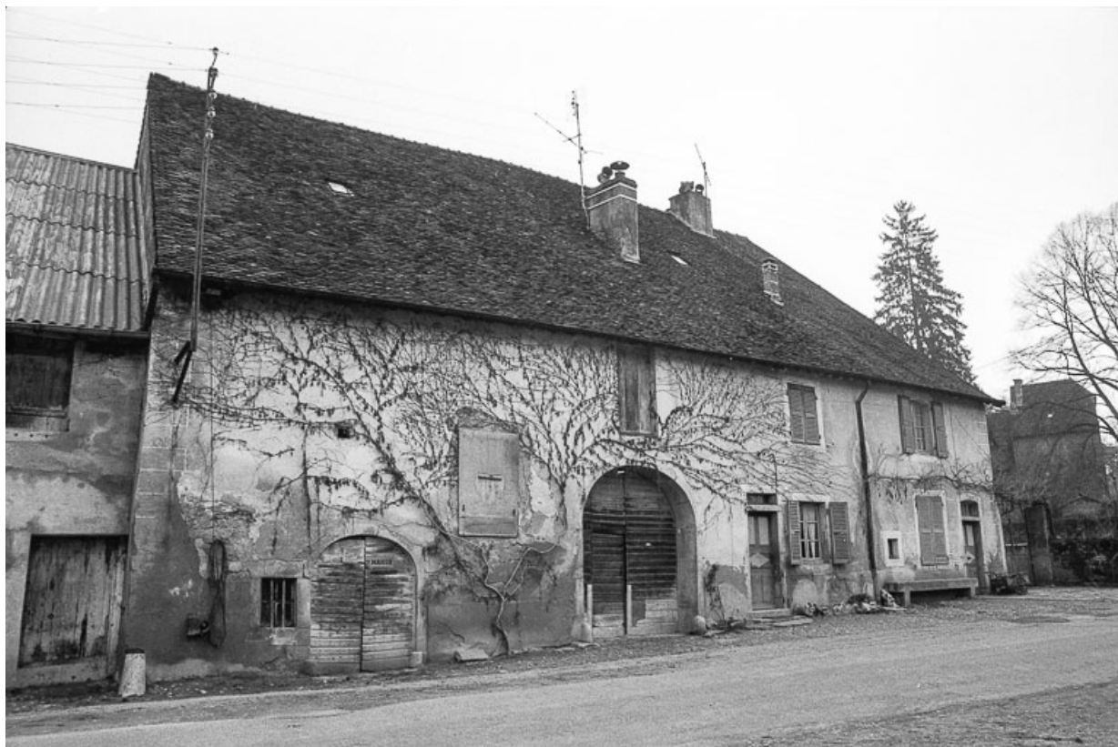
Ferme cadastrée 1965 AD 199, située le long du chemin départemental n° 70 : façade antérieure. 39, Nevy-sur-Seille
