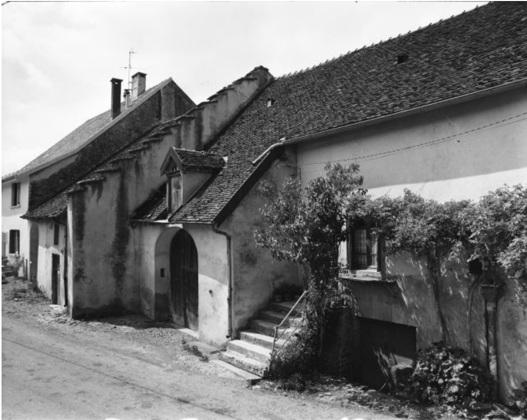
Façade antérieure vue de trois quarts droit. 39, Montain
