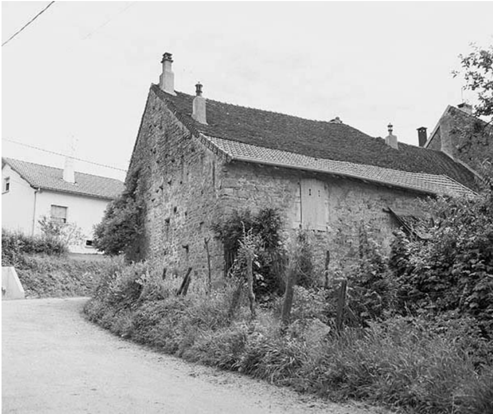
Façades postérieure et latérale droite.
