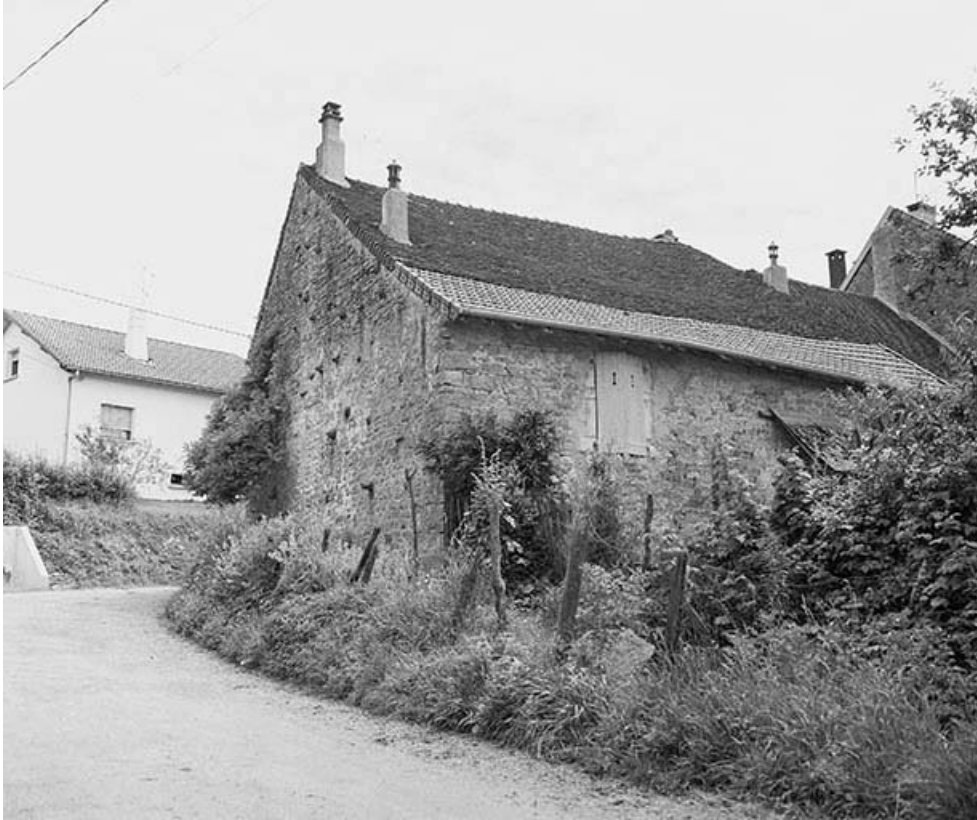
Façades postérieure et latérale droite.
